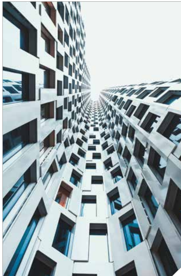
Close up de edifício de concreto
