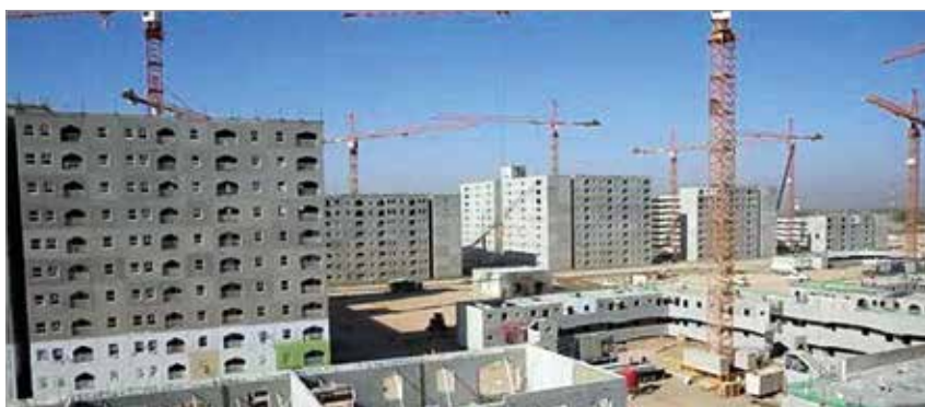
► Figura 2b Canteiro de obras de Bismayah
