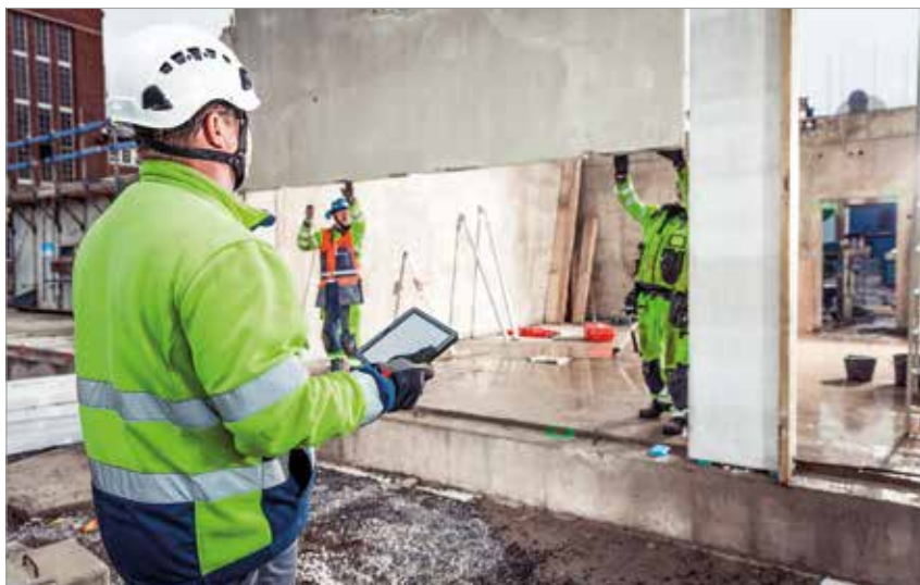
► Figura 2a Instalação de painel pré-fabricado
