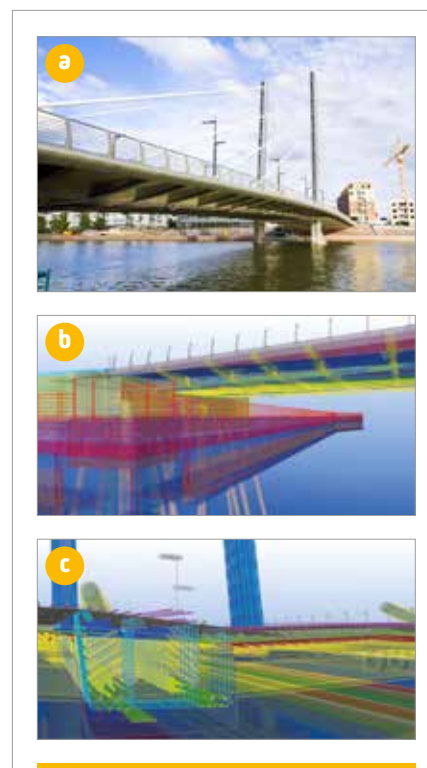
► Figura 11 Ponte finalizada (a) e modelo BIM de obras de arte (b e c), com nível de detalhamento completo de armaduras e insertos metálicos necessários para a construção do projeto, usando software Tekla Structures
