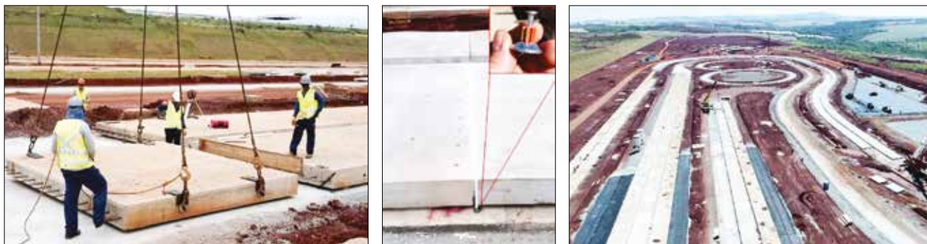
► Figura 8 Montagem; marco topográfico de controle; vista geral de montagem
