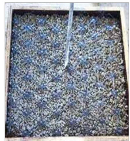
Colocação da malha geossintética
