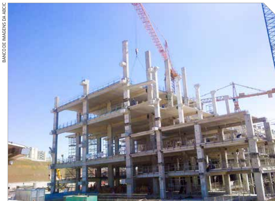
Montagem de prédio com estruturas pré-fabricadas de concreto
