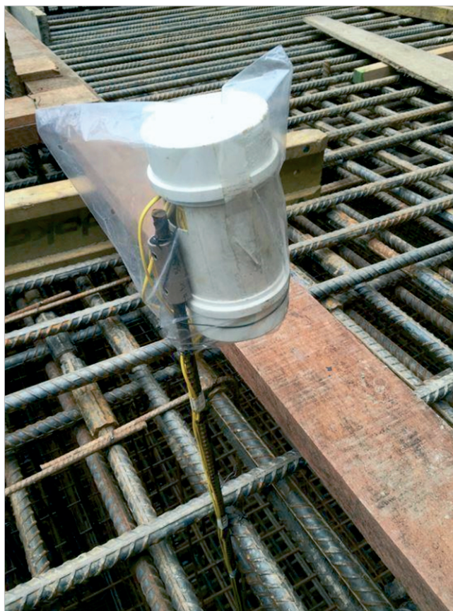
Figura 4 – Detalhe da fixação do termopar e do aquisitor de dados na armação da sapata
