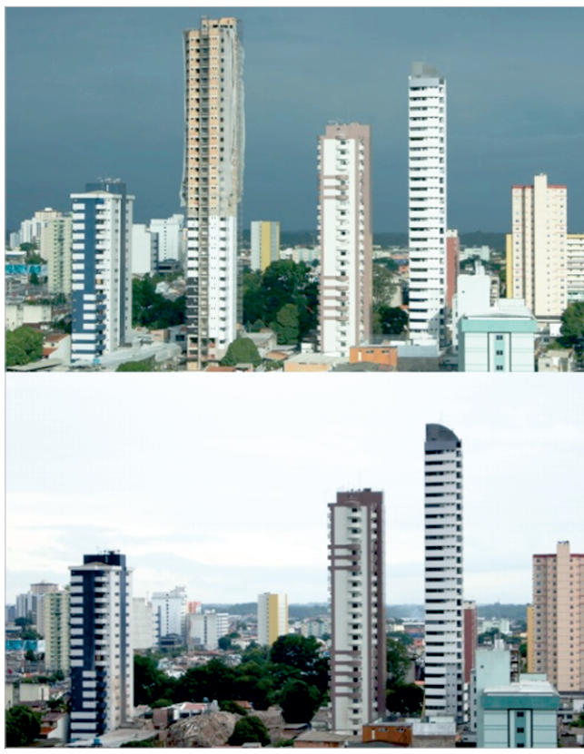
Figure 1 – Collapse of Real Class building (available in http://compradordeimovel.no.comunidades.net/edificio-real-class-construtora-real )
