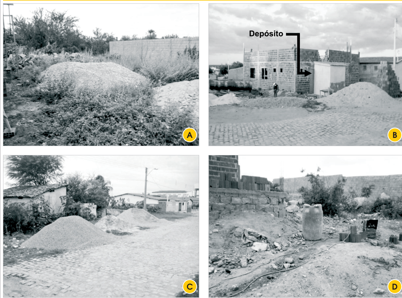
Figura 2 - Disposição dos materiais: a) e c) Materiais dispostos em meio à vegetação, b) Depósito para estocagem de cimento, d) Tambor utilizado para armazenar água
