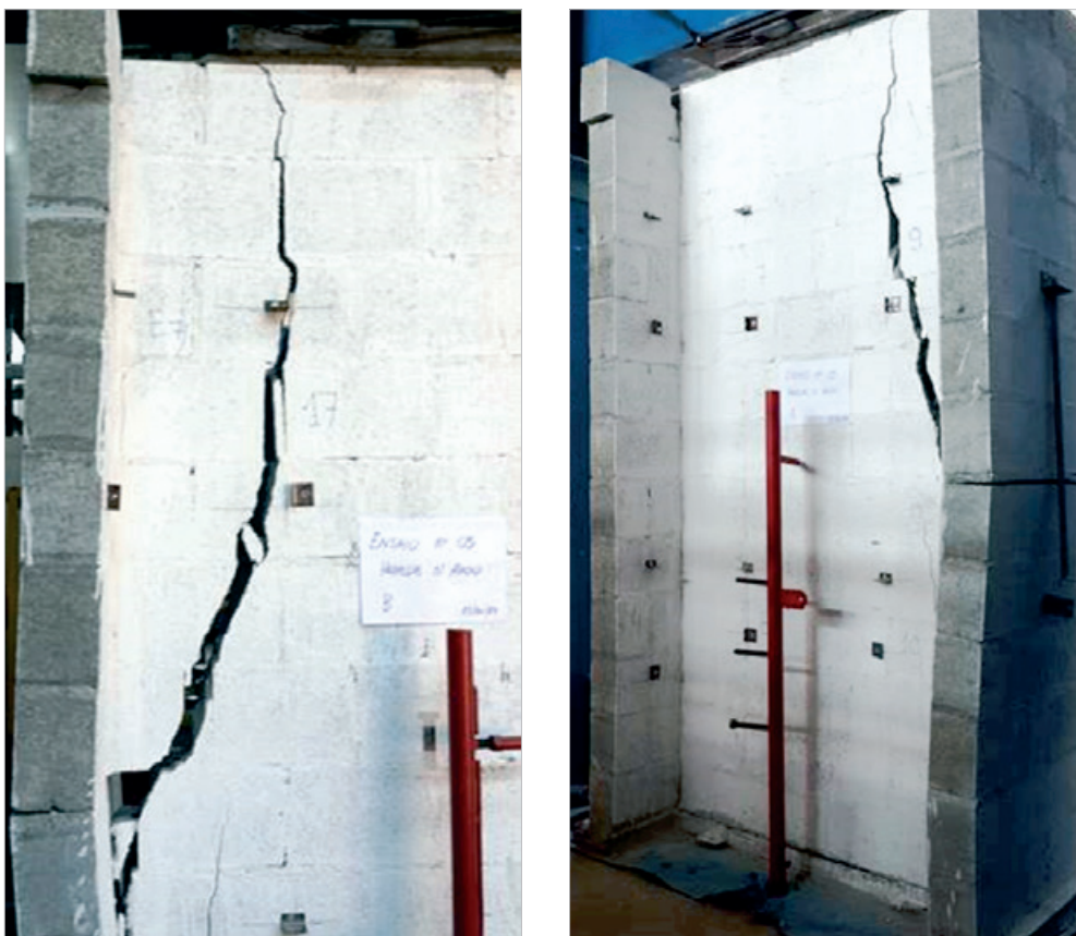
Figura 16 - Ruptura - Parede com flanges sem apoio central 05
