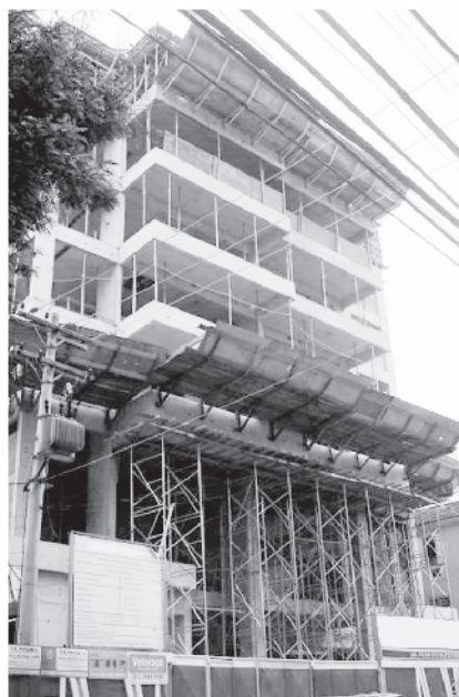
Figura 4 Estágio de construção da 2ª medição
