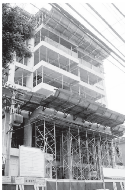
Figura 4 Estágio de construção da 2ª medição
