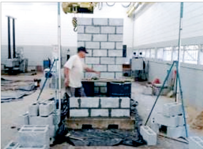
Figura 8 Sequência de montagem das paredes
