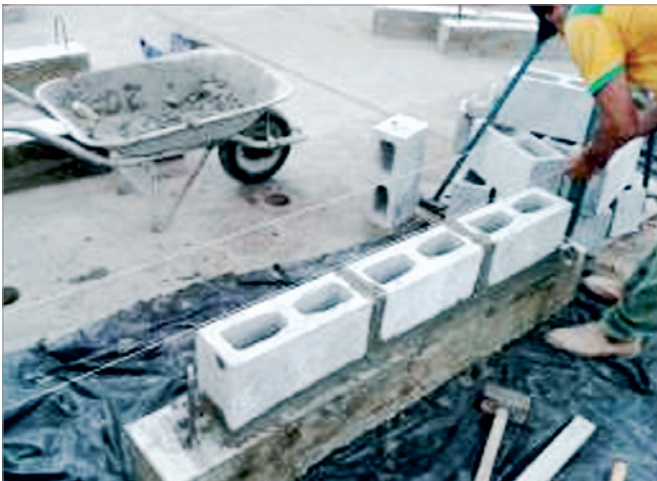
Figura 7 Escantilhões para auxiliar na construção das paredes
