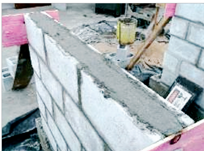
Figura 4 Moldagem dos corpos-de-prova cilíndricos de graute e grauteamento das paredes
