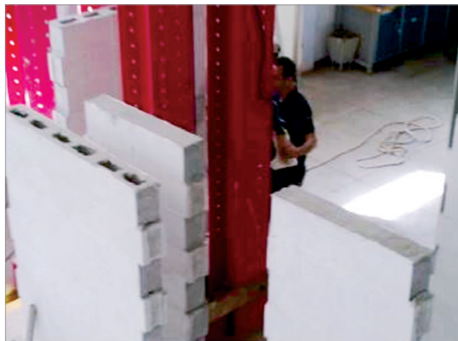
Figura 15 Ilustração do capeamento das paredes com argamassa
