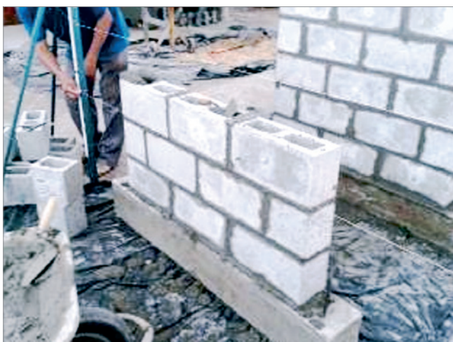
Figura 9 Ilustração das paredes ocas (sem grauteamento)
