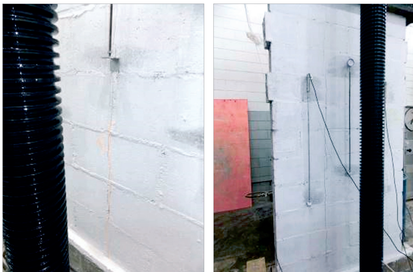
Figura 31 Modo de ruptura das paredes grauteadas
