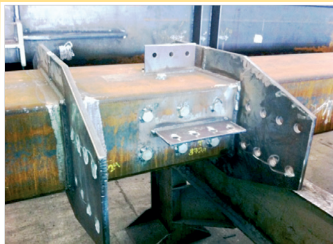
A Ligação com chapa soldada direto
