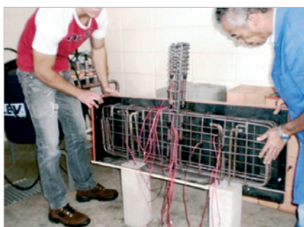
Montagem das armaduras dos blocos nas fôrmas
