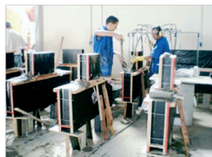
Concretagem dos blocos
