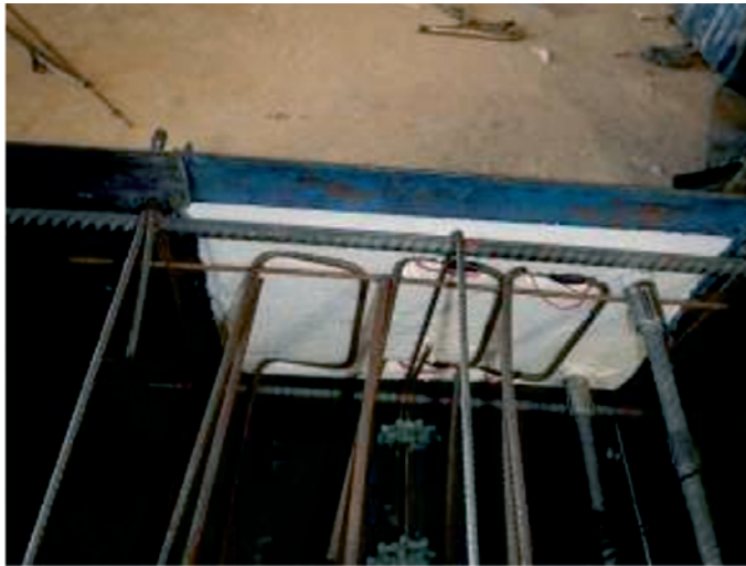
(a) Posicionamento da placa de isopor para formação da chave de cisalhamento e detalhe da armadura normal à interface antes da concretagem do pilar (modelo P2).
