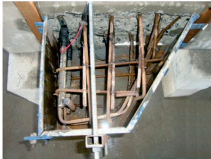
(c) Interface consolo-pilar escarificada e armadura retificada e pronta para a concretagem do consolo (modelos P3, P4 e P5)
