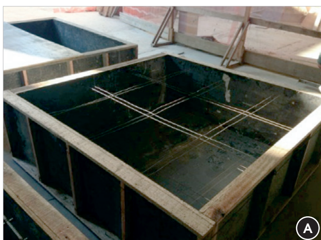
Figura 2 (a) Parede sem armadura (b) parede com armadura
