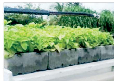
C vista em detalhe do protótipo com telhado verde com blocos de Concreto sobre a laje
