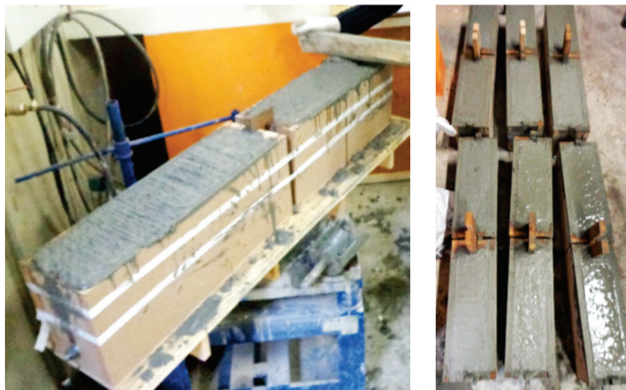
Figura 2 - concretagem de conjunto de vigas para ensaio de aderência entre a barra e o concreto
