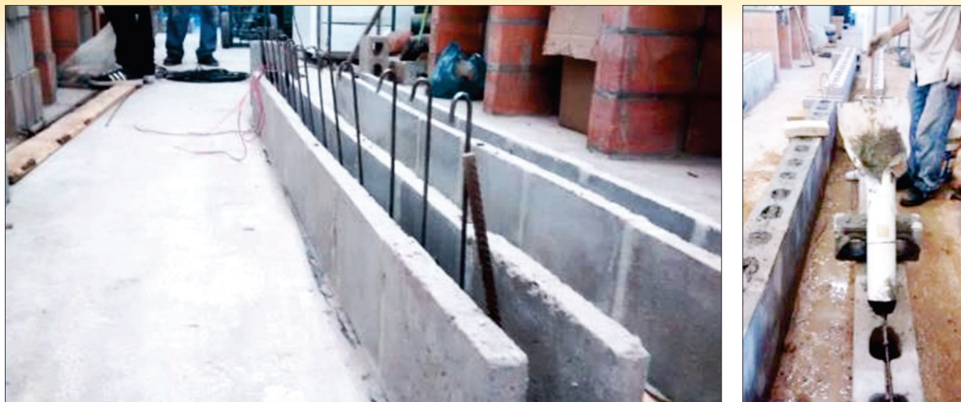
Figura 9 Primeira fiada com estribos (esq.) e grauteamento (dir.)
