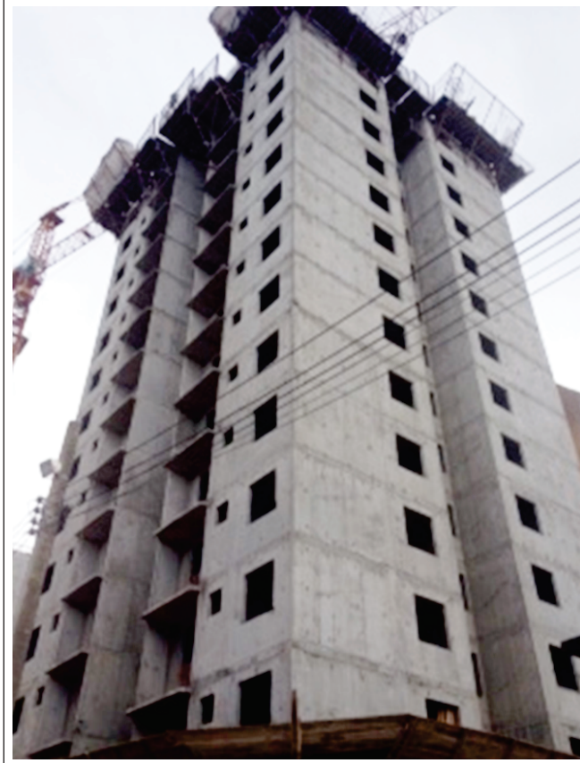
Figura 1 – Edifício Condomínio das Árvores em fase de construção – 13 pavimentos tipo concretados
