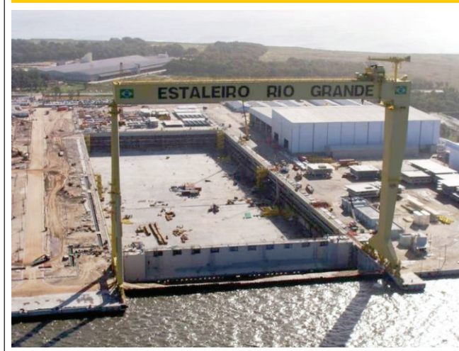
Figura 3 – Vista aérea do dique seco do estaleiro Rio Grande - ERG I
