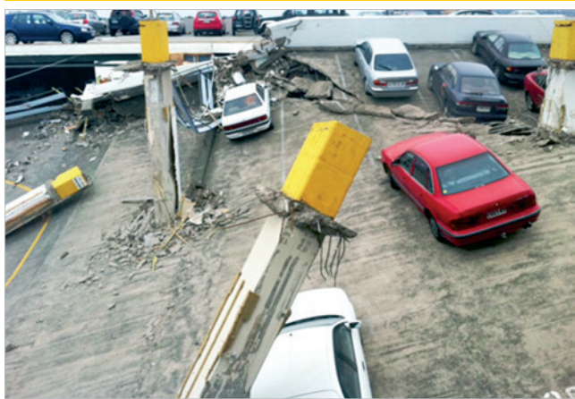
Figura 1 – Ruptura por punção em pavimento com lajes lisas (Middleton (1))
