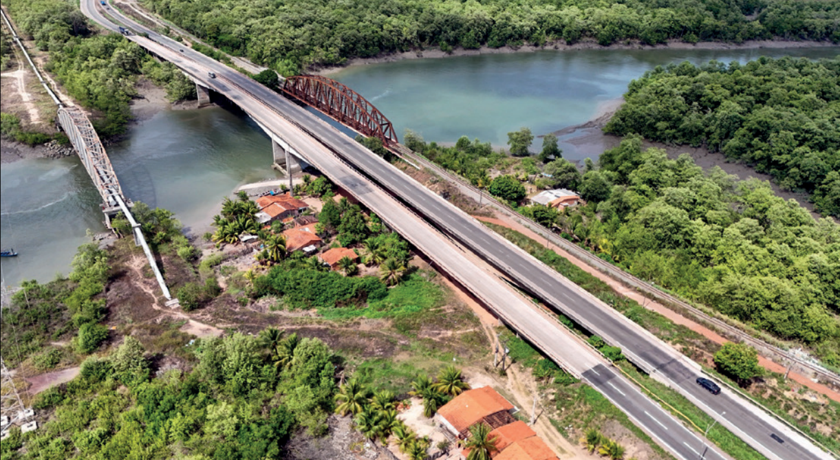
Ponte sobre o Estreito dos Mosquitos, na BR-135/MA
