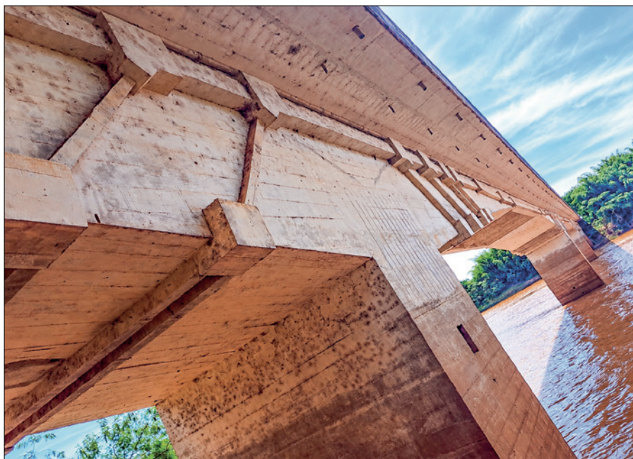
Vista lateral da Ponte sobre o Rio Piquiri, na BR 272/PR, onde se observa a protensão externa realizada
