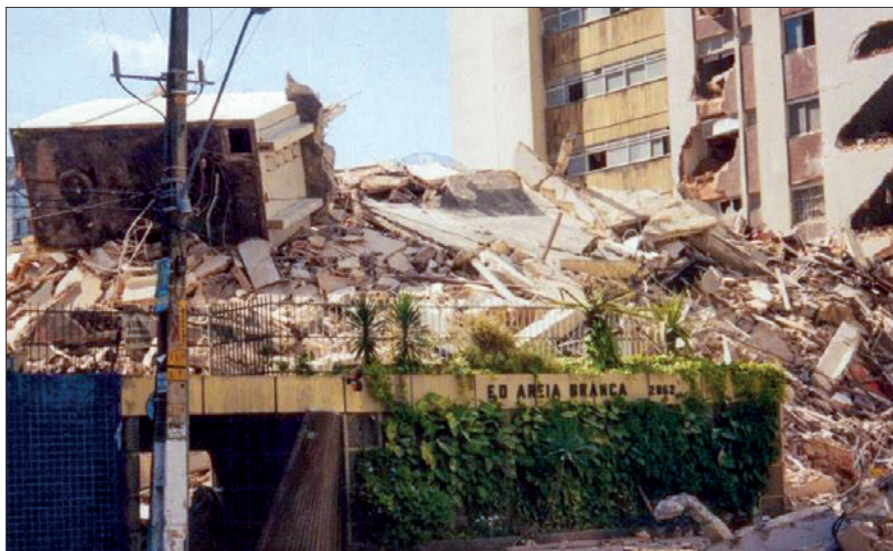
Figura 2 — Edifício Areia Branca, colapsado em 2004 (Acervo dos autores, 2004)
