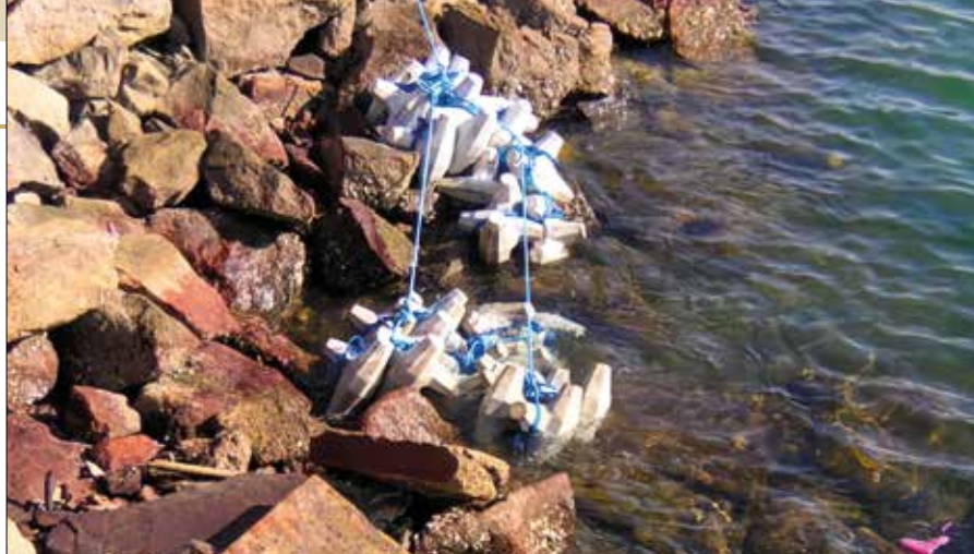
Quebra-mares com uso de escórias de alto-forno desenvolvido na UFES
