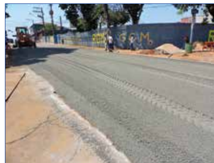
TRECHO 3 – BGTC – Brita graduada tratada com cimento
