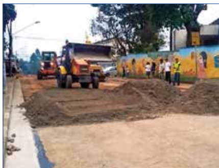
TRECHO 2 – BG N TC R – Brita graduada natural tratada com cimento reciclado
