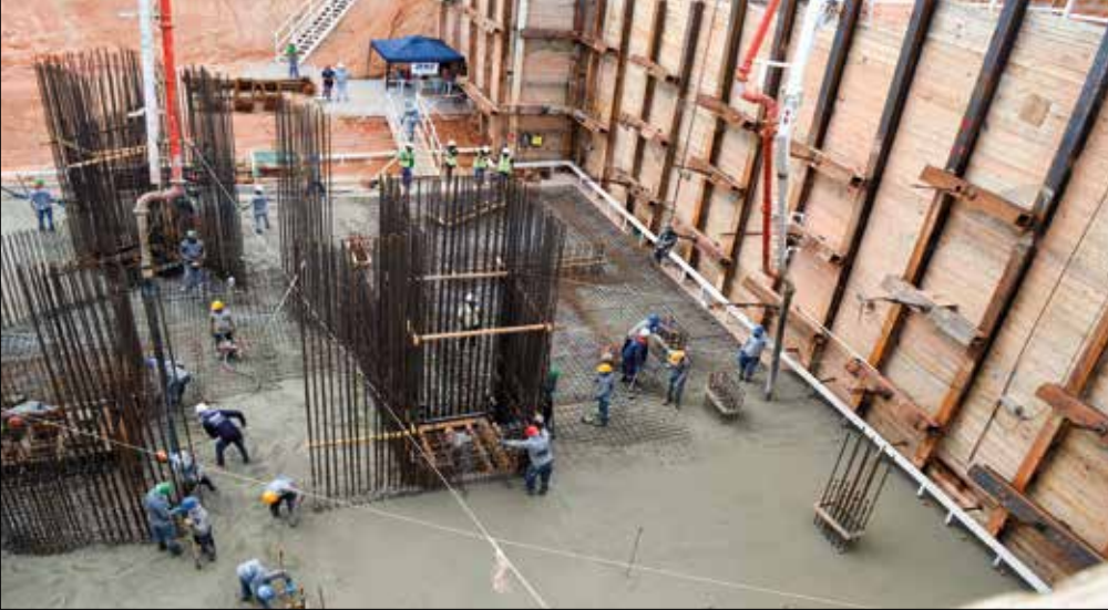
Vista geral da concretagem do bloco de fundação com concreto bombeável. Fonte: Funahashi Jr et al. (2023)
