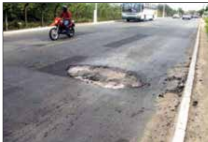
FIGURA 1 PANELAS NO RECAPEAMENTO ASFÁLTICO
