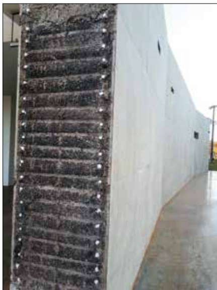
Parede de concreto aparente do túnel de blindagem do acelerador de partículas Sirius
