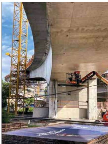
Impermeabilização do concreto aparente do viaduto de acesso a Osasco
