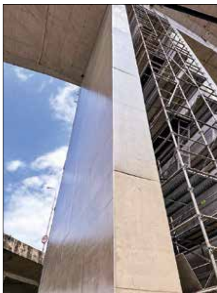
Pilar em concreto aparente do novo viaduto de acesso a Osasco
