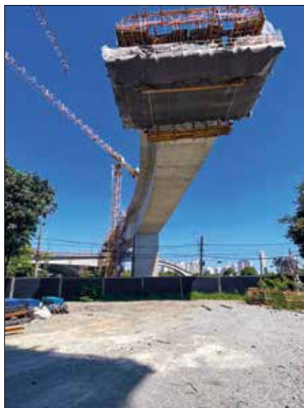
Avanço do tabuleiro do viaduto de acesso a Osasco
