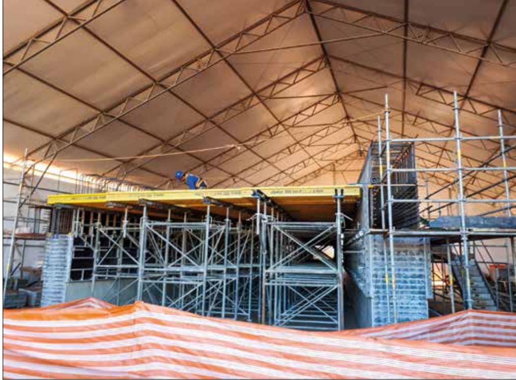
Montagem das fôrmas para estrutura do Projeto Sirius
