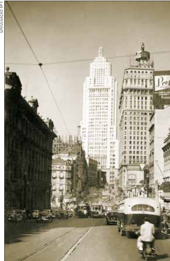
Figura 4 — Edifícios Azevedo Villares e Altino Arantes — antiga sede do Banco do Estado de São Paulo — construídos com base em estudos realizados pela Seção de Solos e Fundações do IPT
