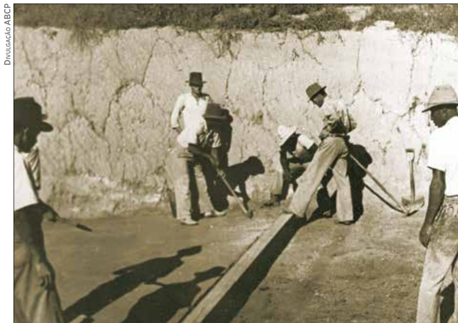
Figura 5 — Tecnologia do solo-cimento sendo aplicada na pavimentação do Aeroporto de Petrolina, na década de 1940
