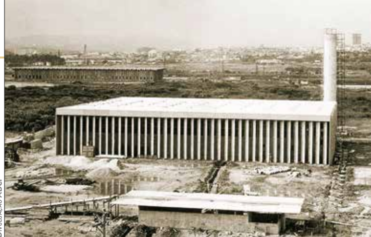
Figura 12 — Centro Tecnológico do Cimento, futura sede da ABCP, em construção em 1976
