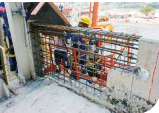
Recuperação de um trecho de uma viga parafeito atingida pelo impacto do segmento metálico da cobertura na Arena Corinthians
