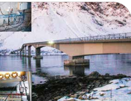
Ponte Gimsøystraumen em Lofoten, na Noruega, protegida catodicamente por corrente impressa e monitorada remotamente pela Norwegian Road Administration
