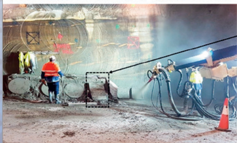
Preparação das amostras para o ensaio de viga pela projeção do concreto com fibras na frente de escavação do túnel
