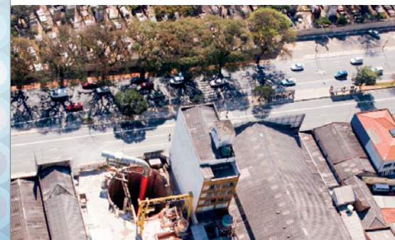
Poço da Linha 4 do Metro de São Paulo, localizado na Rua da Consolação, viabilizado com concreto projetado
