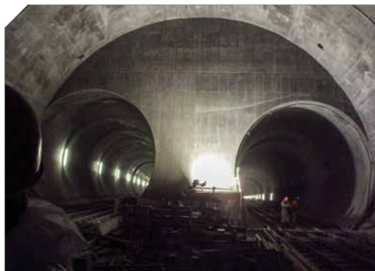
Túnel São Gotardo, na Suíça, em sua fase de construção
