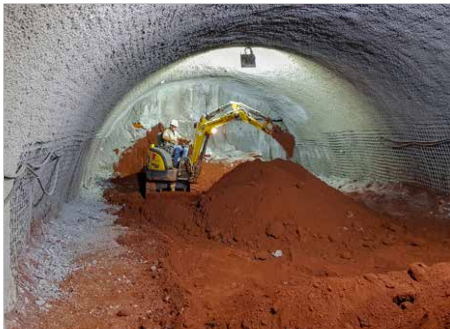
Foto 5 – Mini-retroexcavadeira trabalhando no interior do túnel
