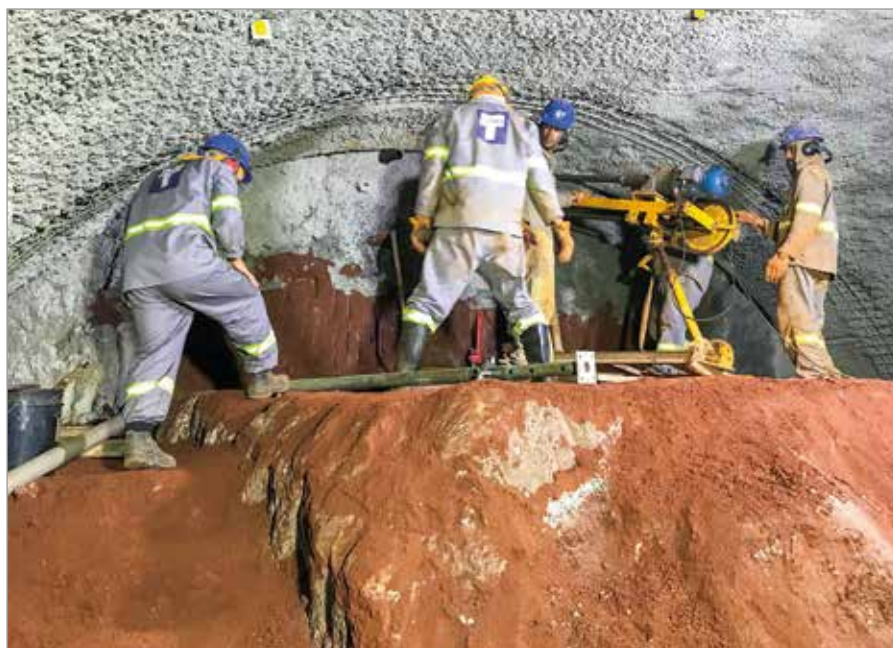
Foto 7 – Execução das enfilagens
