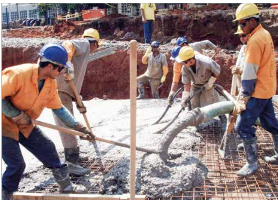
Foto 7 — Concretagem da capa sobre as vigas de cobertura
