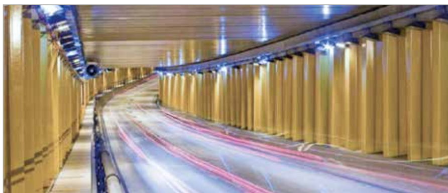
Foto 4 — Túnel Paulo Autran – interior
