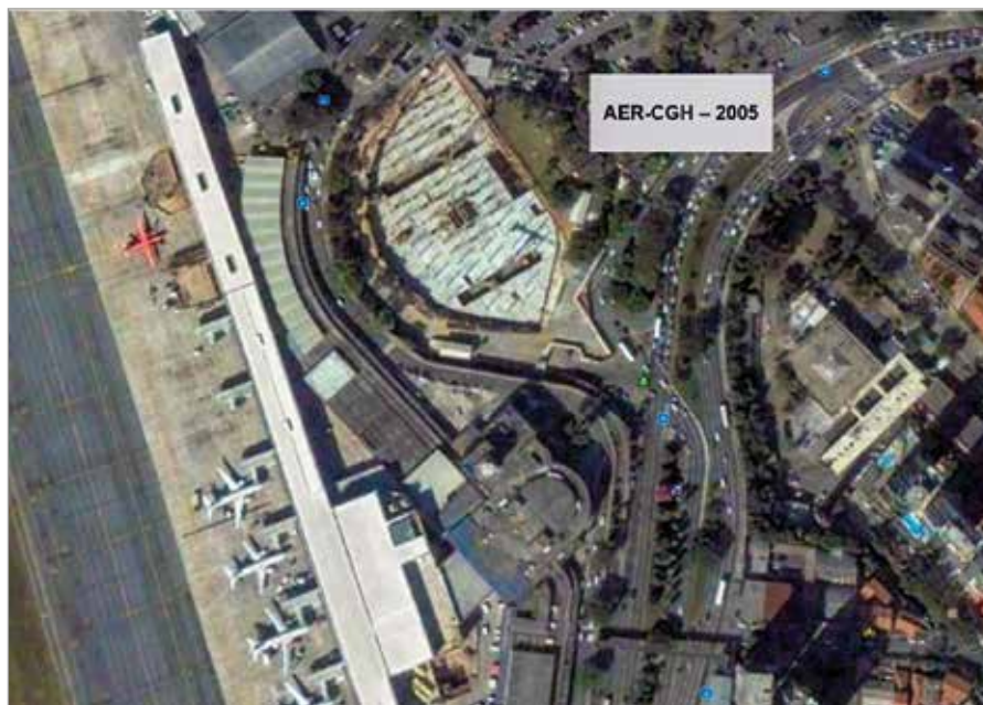
Foto 1 – Antes do túnel (2005)
