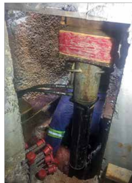
Foto 3 – Execução de estaca-mega metálica reagindo contra a viga portal já executada
