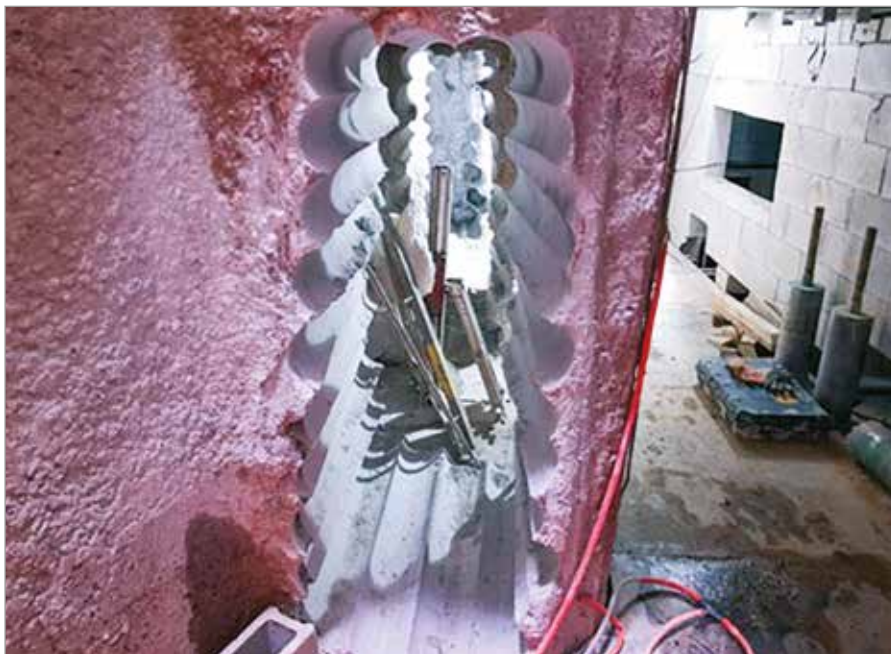
Foto 1 – Recortes nos estacões para execução da viga portal (feitos com serra-copo)
