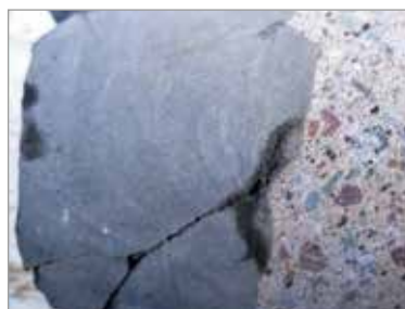
► Figuras 13 e 14 Inspeção visual dos testemunhos extraídos
