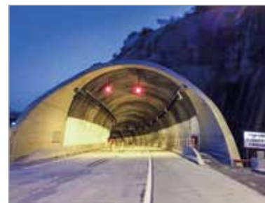
► Figura 15 Aspecto geral do túnel, com revestimento em concreto projetado com aditivo cristalizante – Linha 3 do Metrô de Santiago do Chile
