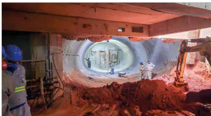
Foto 10 – Revestimento do túnel concluído
