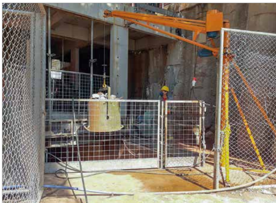
Foto 6 – Caçamba utilizada no transporte vertical
