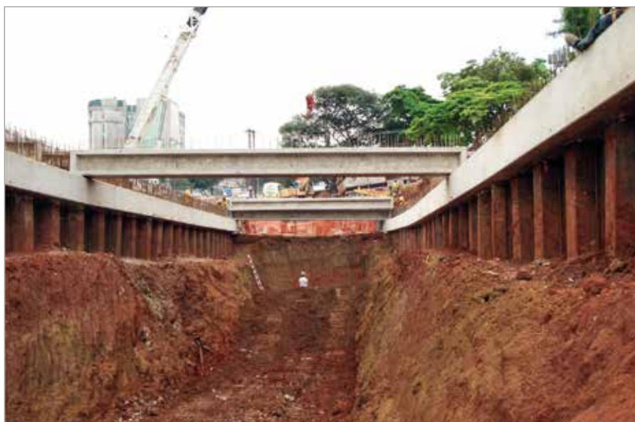
Foto 5 — Escavação após a cravação das estacas-prancha, vigas de coroamento das estacas-prancha e vigas pré-moldadas de cobertura
