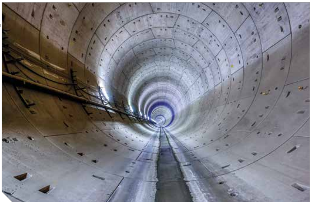
Foto 2 – Túnel Filder, no qual se observa as aduelas de concreto pré-moldado colocadas
