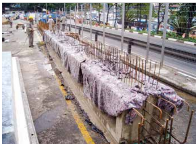
Foto 8 — Etapa final de cura úmida do concreto
