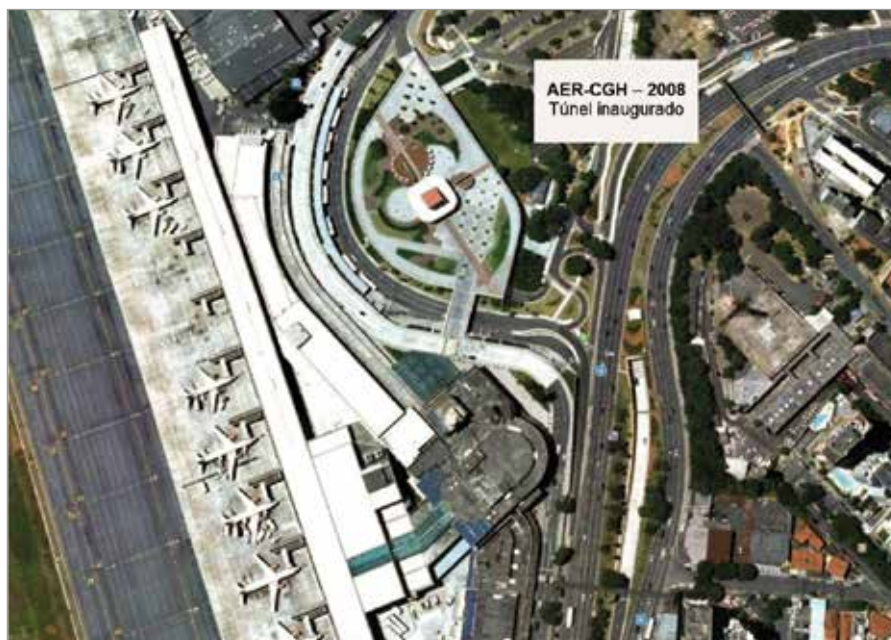
Foto 2 – Depois do túnel (2008)
