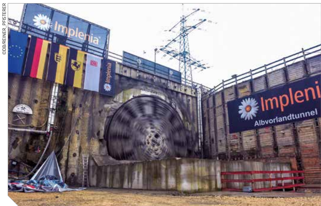
Foto 1 – TBM no emboque do túnel Alborland
