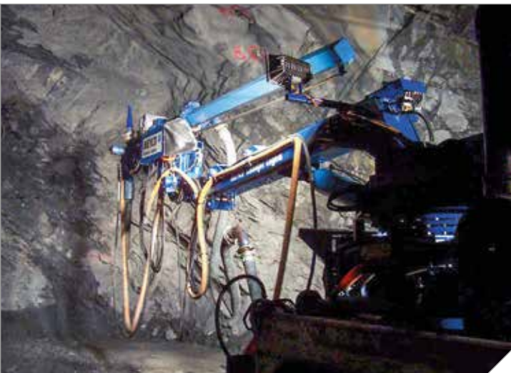
Aplicação de concreto projetado com robô
