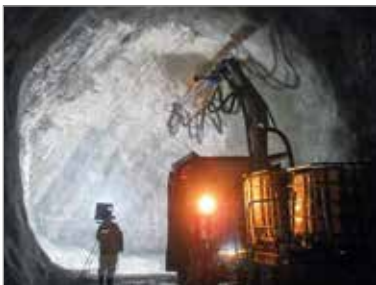
► Figura 8 Lançamento de concreto com fibras com braço robótico de projeção
