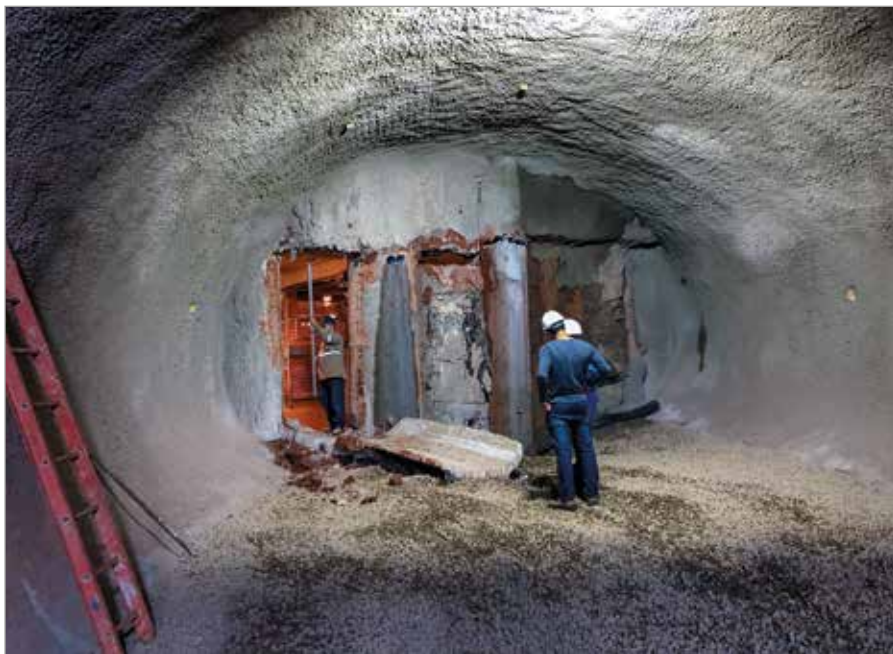
Foto 4 – Desvinculação dos estações e demolição da contenção para conclusão do emboque lado Torre
