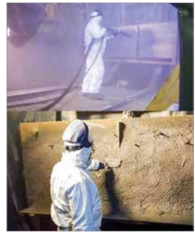
► Figura 9 Aplicação de concreto projetado no banco de ensaios de concreto projetado do Ruhr-University Bochum (TLB, RUB)
