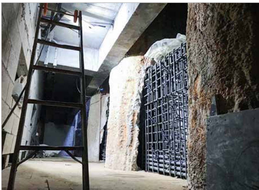
Foto 2 – Armadura da viga portal devidamente instalada
