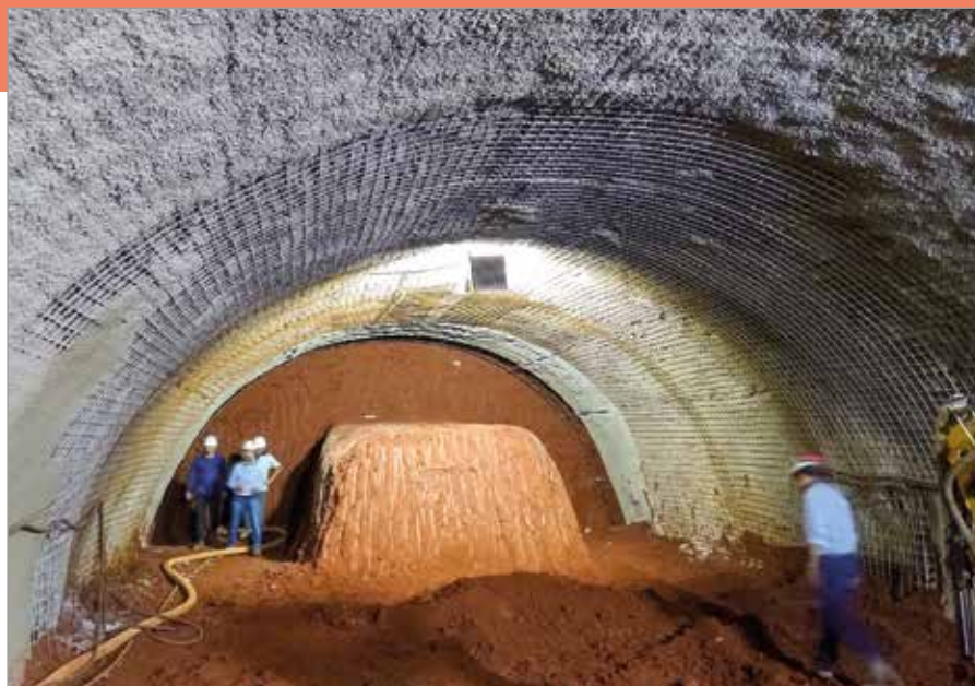
Foto 8 – Frente do túnel com núcleo central / revestimento pronto para receber os 5 cm finais de concreto projetado / arco invertido reaterrado
