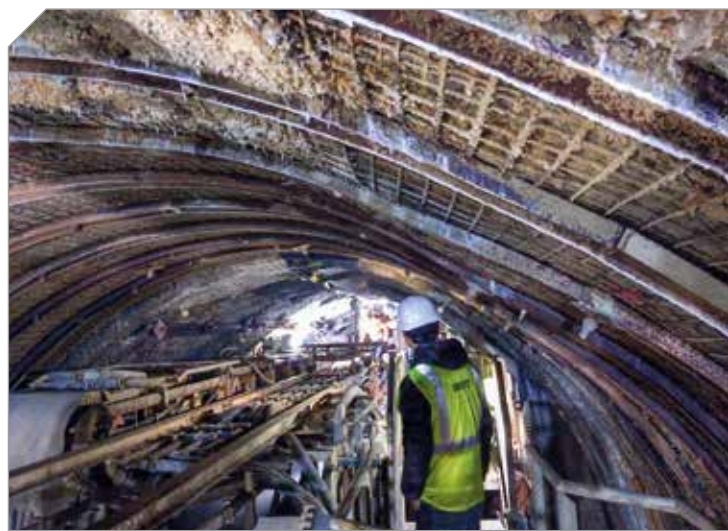
Túnel Brenner entre a Itália e Áustria
