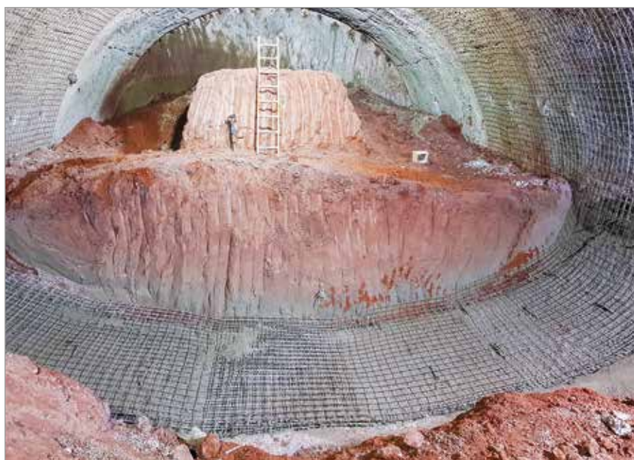
Foto 9 – Execução do arco invertido / frente do túnel
