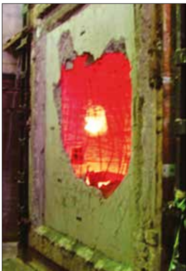
► Figura 3 Elemento de concreto que sofreu lascamento explosivo durante ensaio de resistência ao fogo no forno do LSFEx, no IPT
