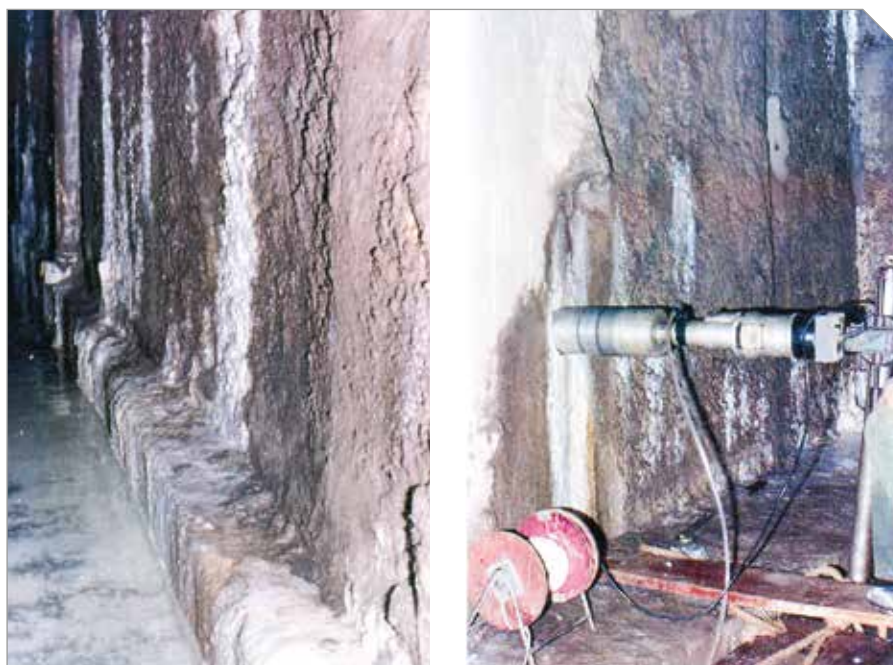
Parede-diafragma da Estação São Bento com lixiviação e carbonatação, e extração de testemunhos para análise
