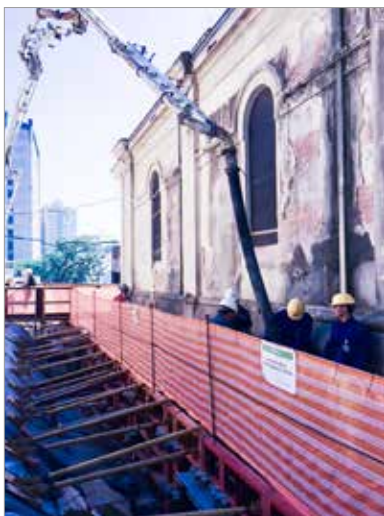
▶ Figura 4 Local de lançamento do concreto do lado de fora
