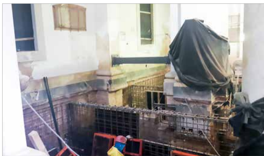
► Figura 3 Montagem das vigas na parte interior
