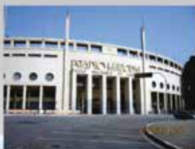
recuperação e reforço de edificações
