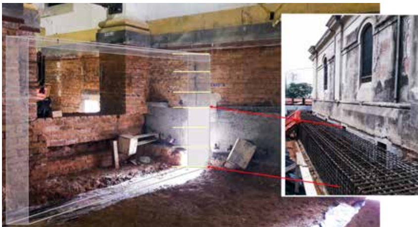
► Figura 2 Intersecção das vigas na parte interna da estrutura
