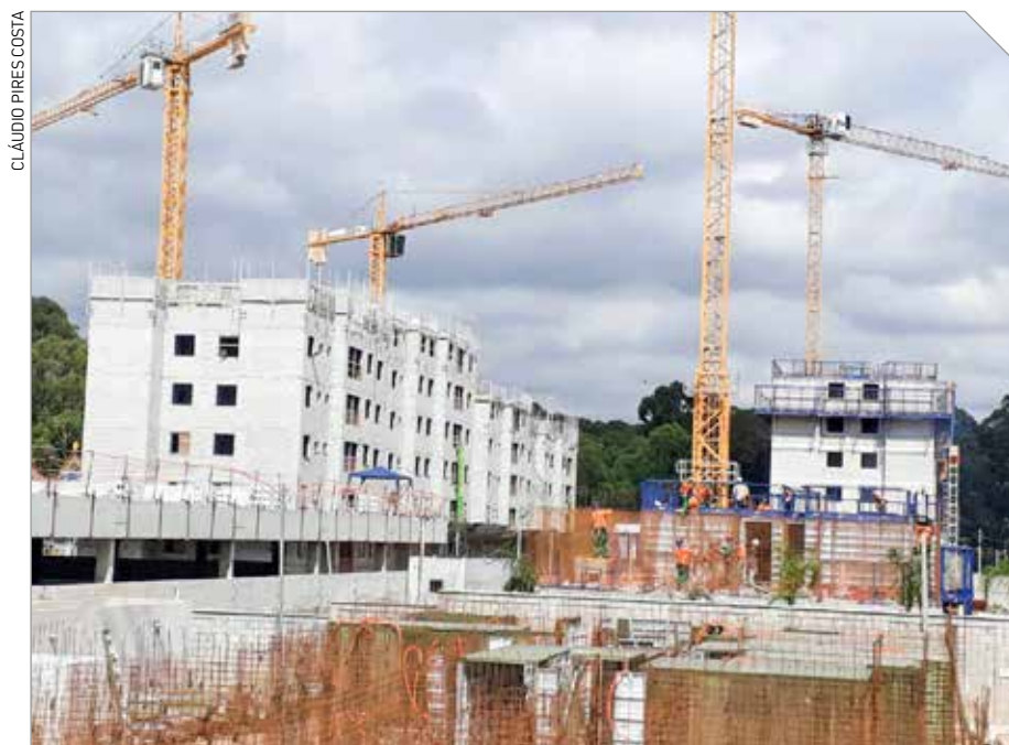
Foto 3 – Obras do empreendimento Spazio San Valentin (à esquerda) em alvenaria estrutural e Grand Reserva Paulista com paredes de concreto (à direita)
