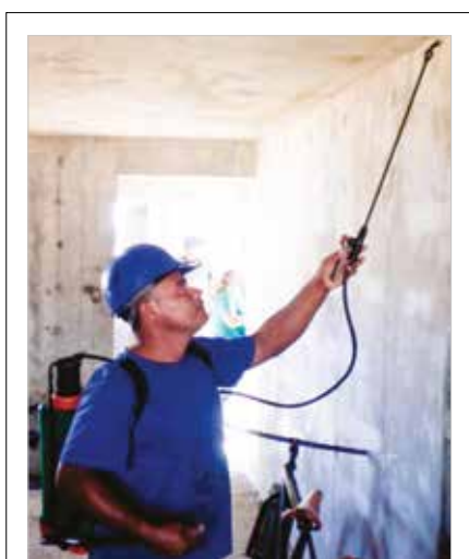
► Figura 2 Aplicação de cura química
