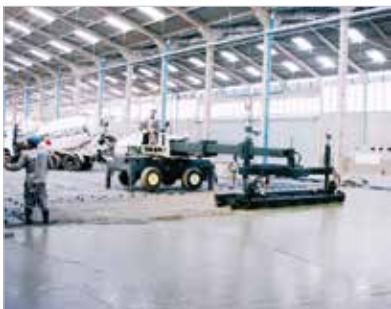
► Figura 3 Distribuidora de concreto com autorregulação de nivelamento
