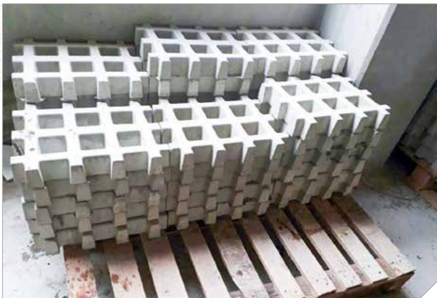
Foto 6 – Reaproveitamento de materiais no canteiro de obras Grand Reserva Paulista e San Valentin
