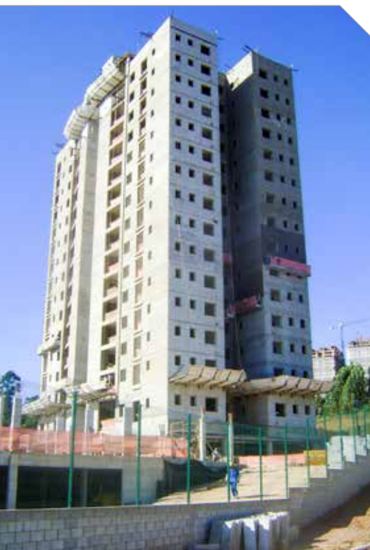
Prédio em Alvenaria Estrutural, em Alphaville (Construtora MPD)
