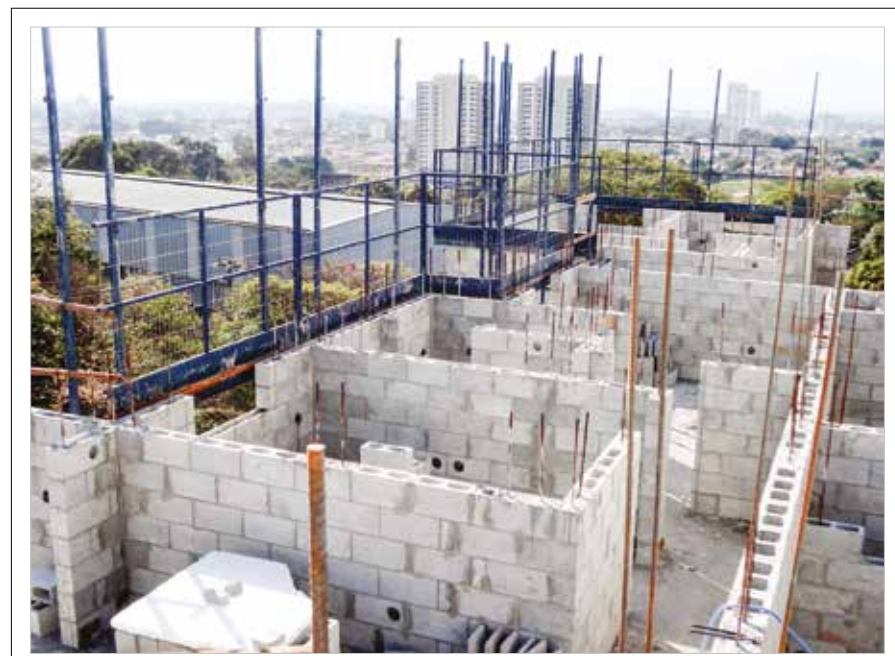
▶ Figura 13 Etapa de assentamento dos blocos até a 7ª fiada
