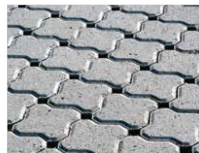
► Figura 4 Peças de concreto com áreas vazadas. Percolação pelos vazados
