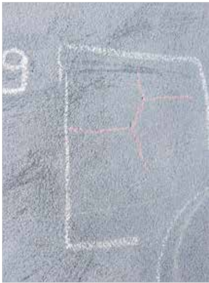
► Figura 2 Fissuração típica dos revestimentos
