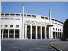
recuperação e reforço de edificações
