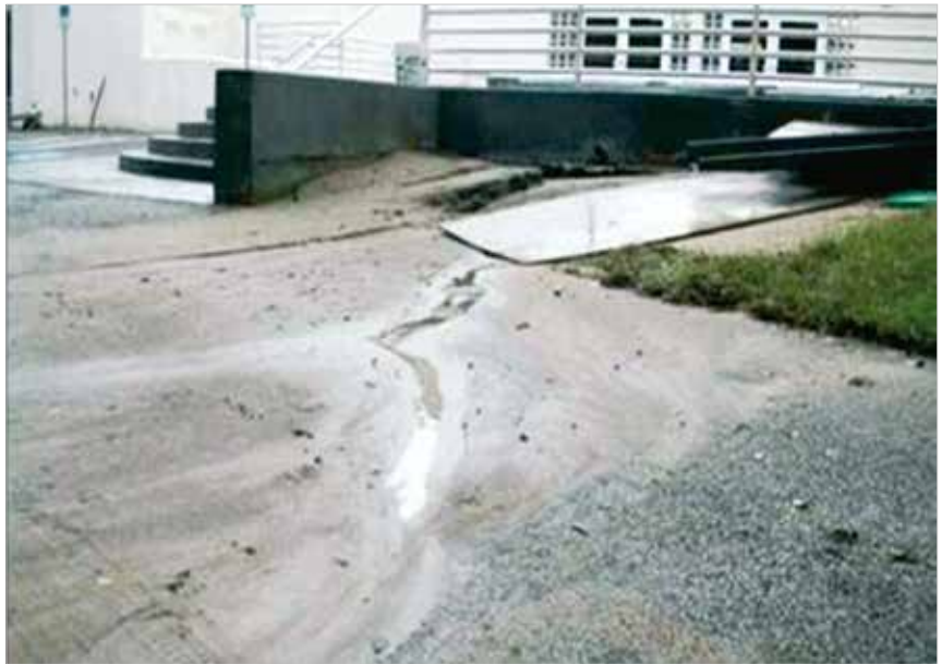
▶ Figura 9 Colmatação devido ao escoamento de detritos de uma área com materiais finos, sem cobertura de vegetação (TONG, 2011)
