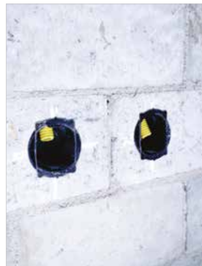
b Bloco com caixinhas instaladas
