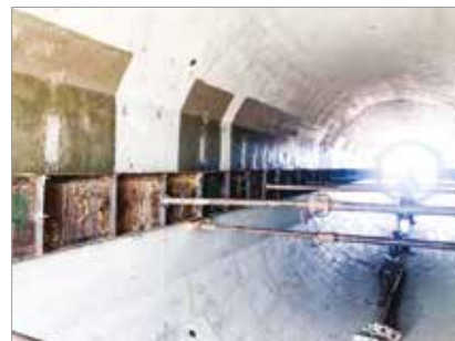
► Figuras 4 e 5 Vista externa e interna - consolidação das aduelas com groute de alta resistência
