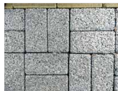
► Figura 5 Peças de concreto poroso. Percolação pelas peças
