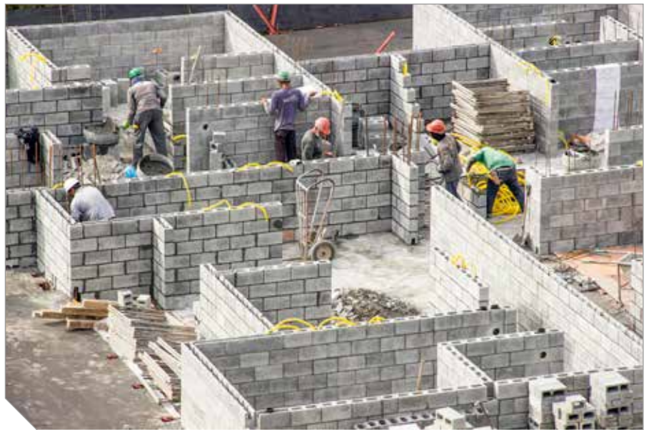
Operários executando a construção de edificação em alvenaria estrutural
