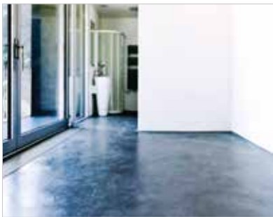
► Figura 1 Aspecto final de piso cimentado, acabamento com resina (Foto AECWeb)
