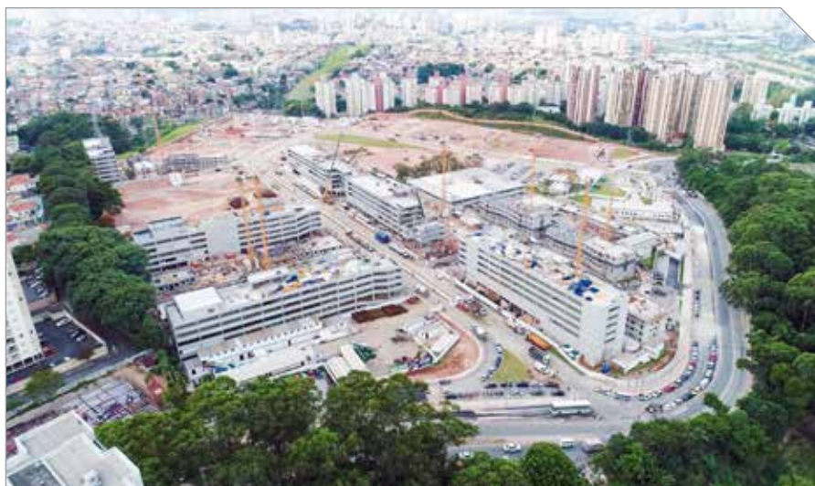
Foto 1 – Perspectiva aérea do canteiro de obras dos empreendimentos Grand Reserva Paulista e Spazio San Valentin
