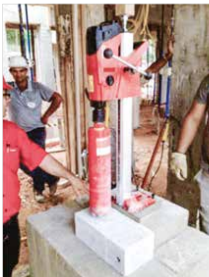
a Furação de bloco com extrusora
