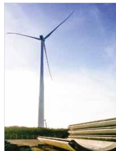
▶ Figura 2 Torre montada – vista frontal
