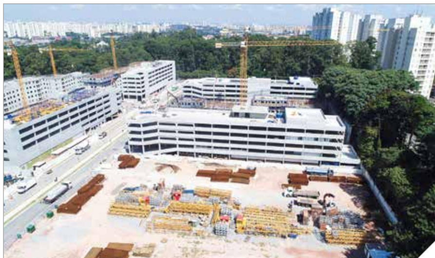
Foto 4 – Unidades de garagens em estágio avançado construídas com elementos pré-moldados
