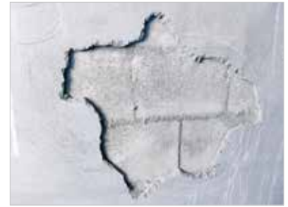
► Figura 3 Em local de som cavo foi retirado o revestimento de argamassa – aderência apenas na região da junta de assentamento da alvenaria
