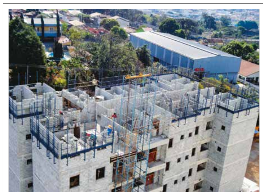
▶ Figura 14 Etapa de assentamento das últimas fiadas
