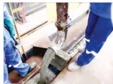
► Figura 3 Lançamento do CAA através da janela de aplicação na fôrma
