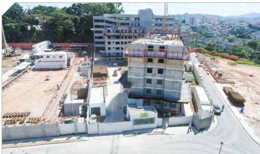
Foto 5 – Prédio com paredes de concreto no canteiro Grand Reserva Paulista
