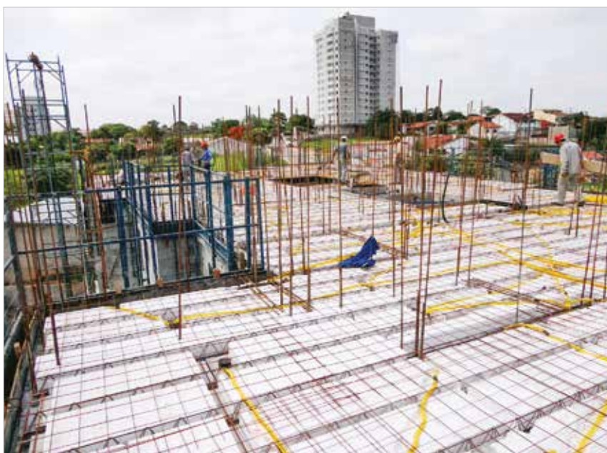
▶ Figura 12 Etapa prévia de concretagem da laje de um pavimento-tipo, com as ferragens de espera dos pontos de graute
