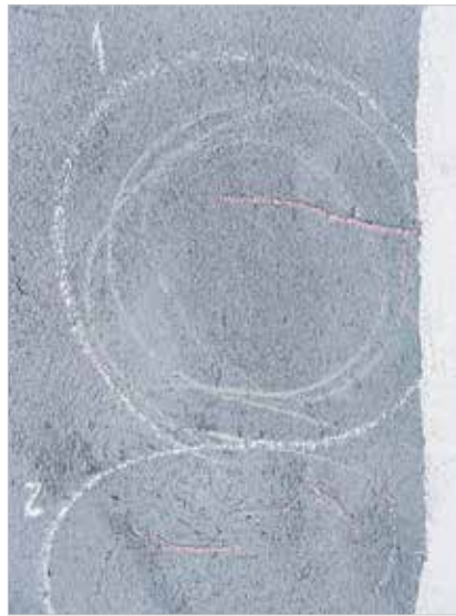
► Figura 3 Em local de som cavo foi retirado o revestimento de argamassa – aderência apenas na região da junta de assentamento da alvenaria
