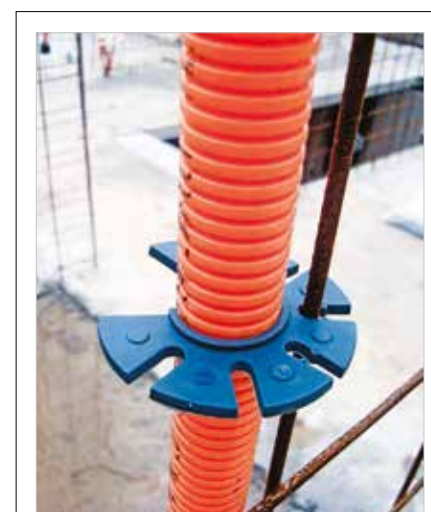
► Figura 3 Eletroduto com espaçador
