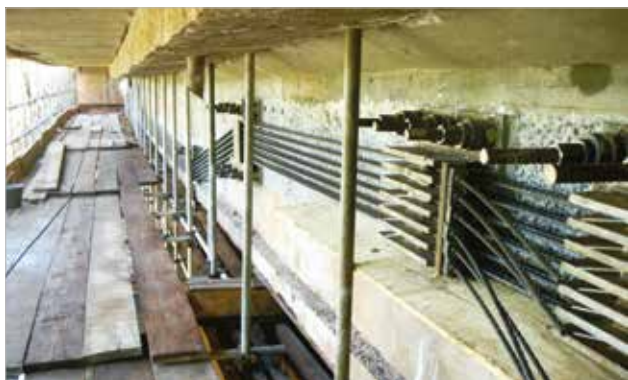
► Figura 7 Vista lateral de uma das vigas principais com as cordoalhas em traçado poligonal
