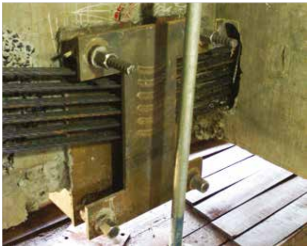
► Figura 9 Detalhe de um desviador e das cordoalhas passando por um furo feito na transversina
