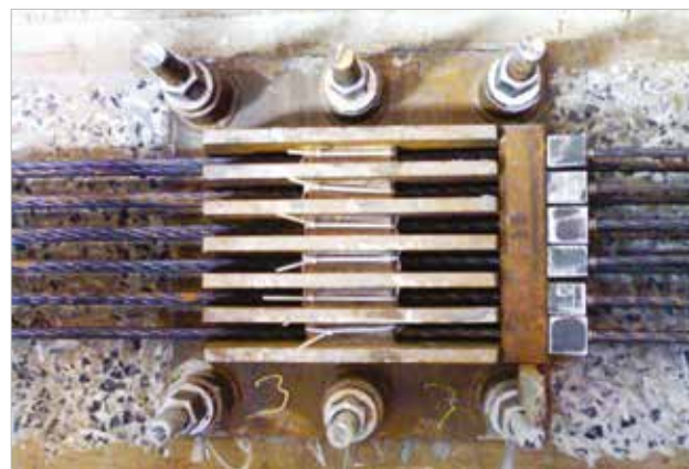
► Figura 8 Detalhe de uma das ancoragens utilizadas
