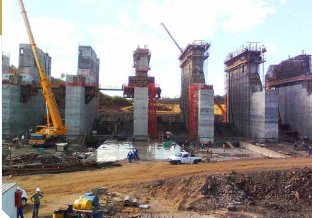
Obras da Barragem de São João, no Rio Grande do Sul
