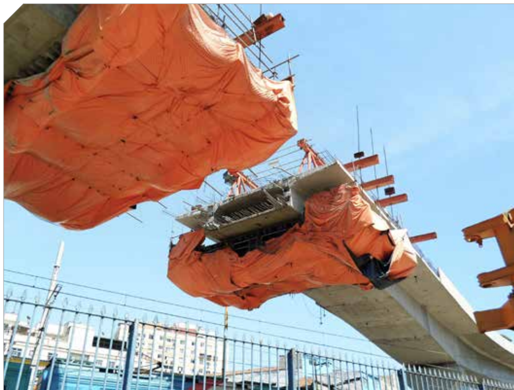
Ponte em balanços sucessivos da Transcarioca, no Rio de Janeiro
