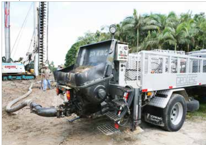
Instalação das estacas instrumentadas, para análise do comportamento de fundações profundas
