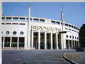
recuperação e reforço de edificações
