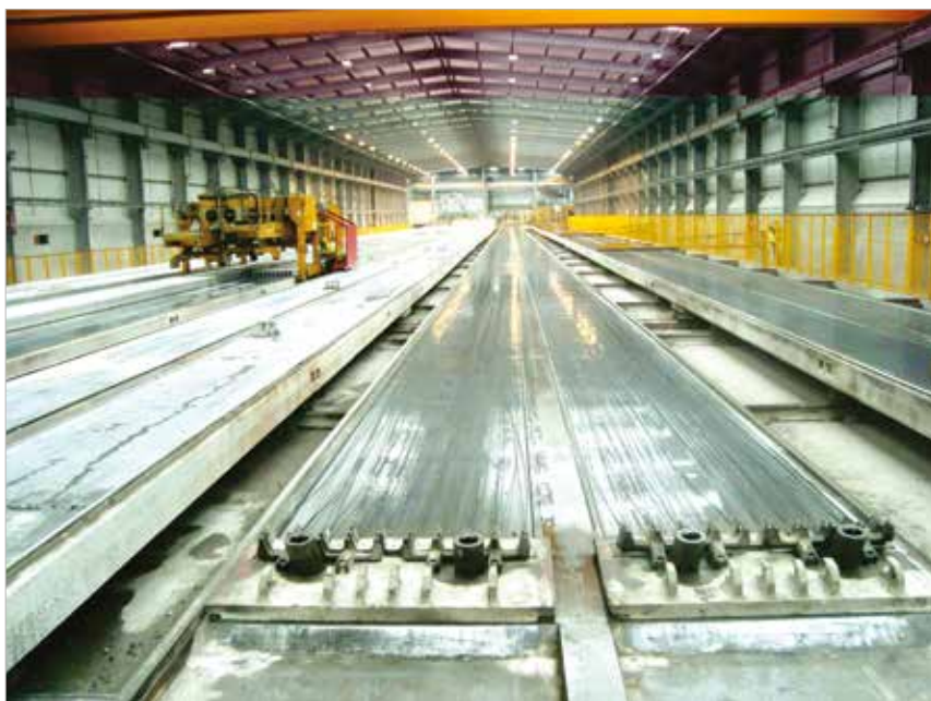
► Figura 1a Fábrica de lajes alveolares em sistema carrossel, na Inglaterra. (Arquivo Abcic: Missão Técnica 2008)
