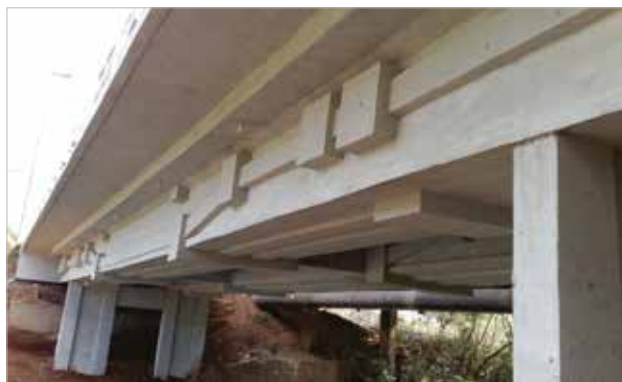
► Figura 10 Aspecto da obra após a realização do reforço
