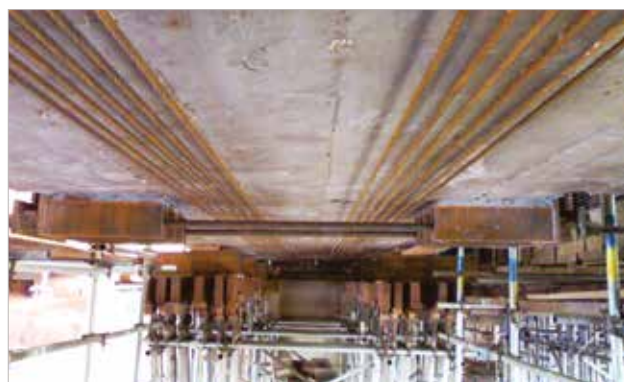
► Figura 6 Cordoalhas na face inferior de uma das vigas principais
