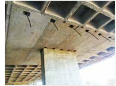
► Figura 4 Detalhe da “protensão chapéu” realizada nas regiões maciças
