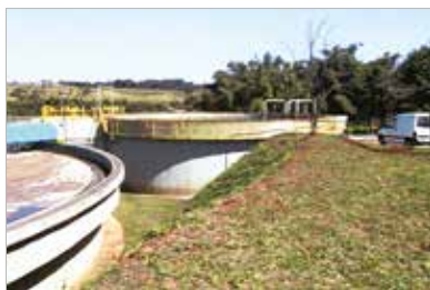
► Foto 2 Tanques de concreto armado em indústria de papel e celulose
