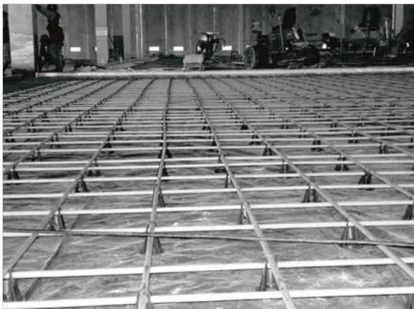
► Figura 3 Malha de cabos de protensão
