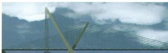
Detalhe dos estais do projeto
