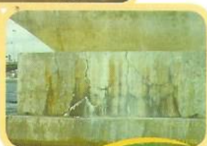
Detalhe da Ponte Paulo Guerra
