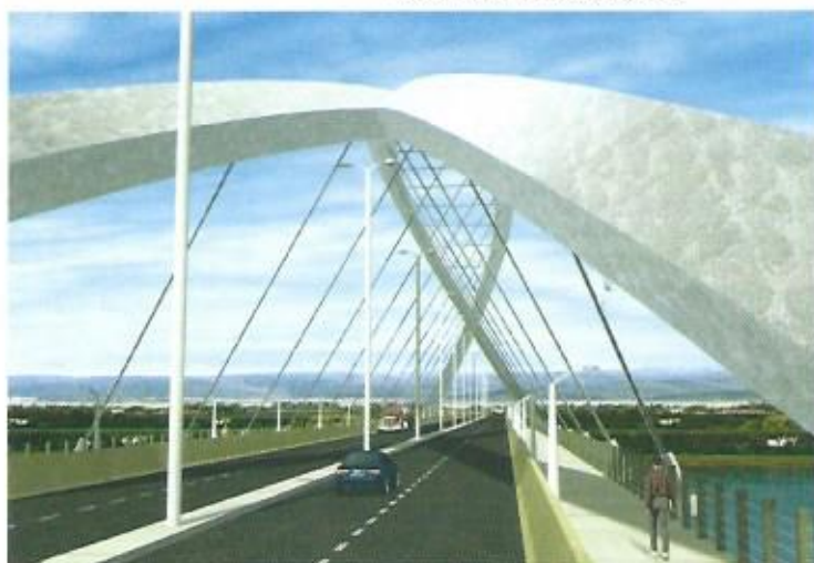
Vista frontal da ponte
