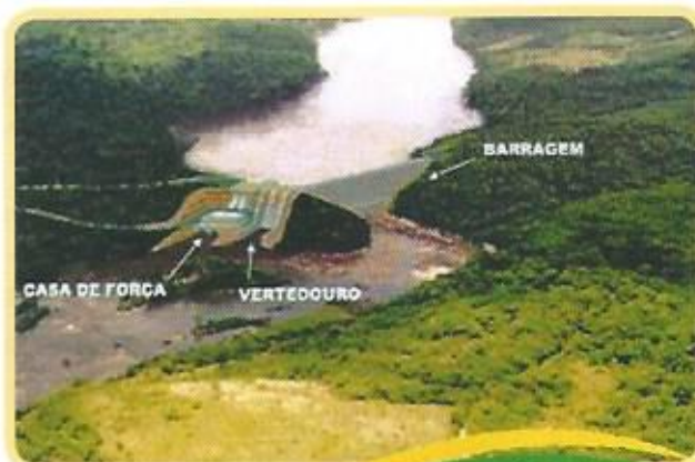
Esquema de uma barragem.
