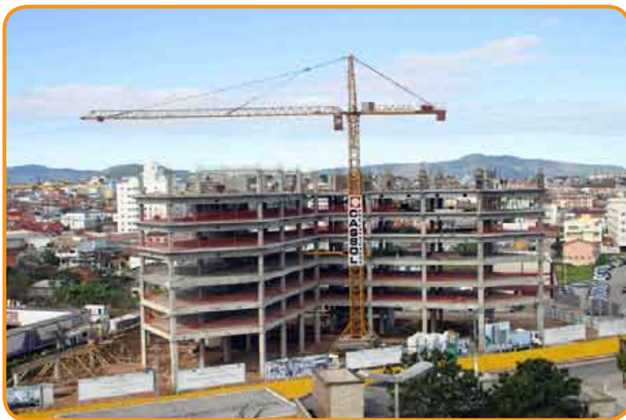
Execução dos pavimentos
