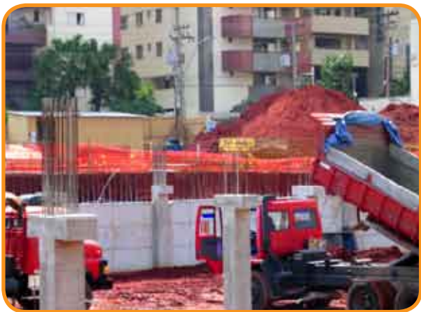
Fig. 1 – Pilares e consolos Moldados "in loco".
