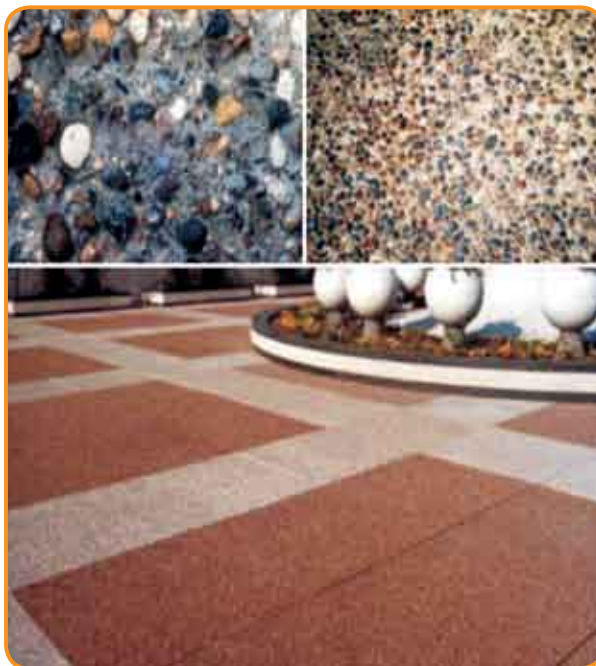
Placas de concreto com agregados em três níveis de análise
