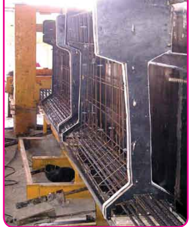
Figura 8 – Peça do tipo I com elevada taxa de armadura
