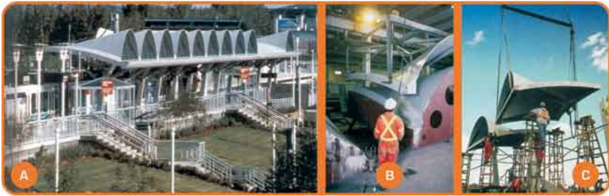
Fig. 3 – Cobertura em casca de estação ferroviária no Canadá com 20mm de espessura: a) cobertura pronta, b) desmoldagem de componente e c) montagem de um módulo [VICENZINO, (2005)]
