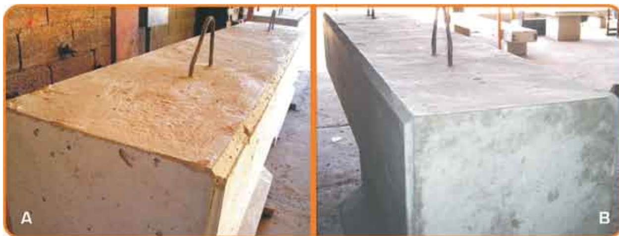
Figura 9 – Peça após concretagem. A – moldada com concreto corrente. B – moldada com concreto auto-adensável.
