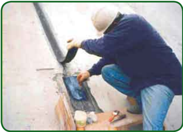
Emenda com a junta perimetral
