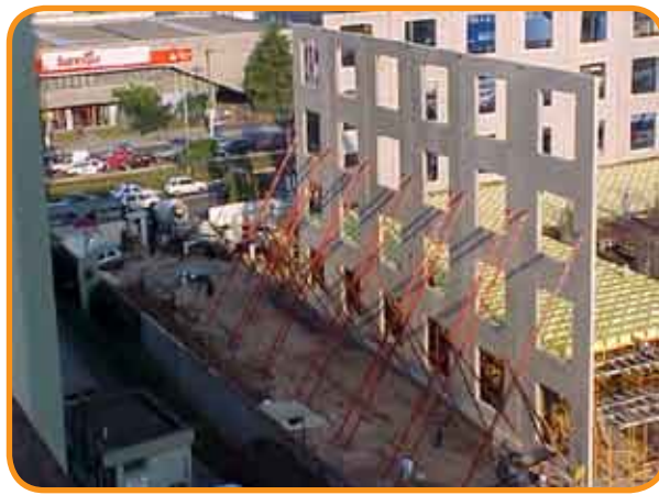
Fig. 9 – Painéis “TILT UP” e lajes nervuradas em montagem.
