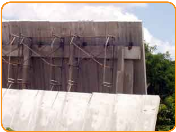
Fig. 7 – Estrutura montada. Notar as ligações superiores.
