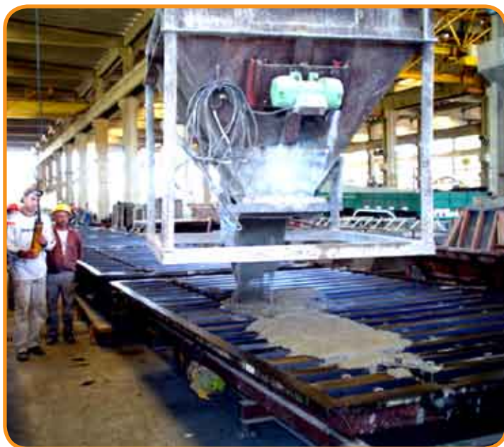
Figura 2 – Concretagem com o CAA com poucas pessoas, na empresa "A".
