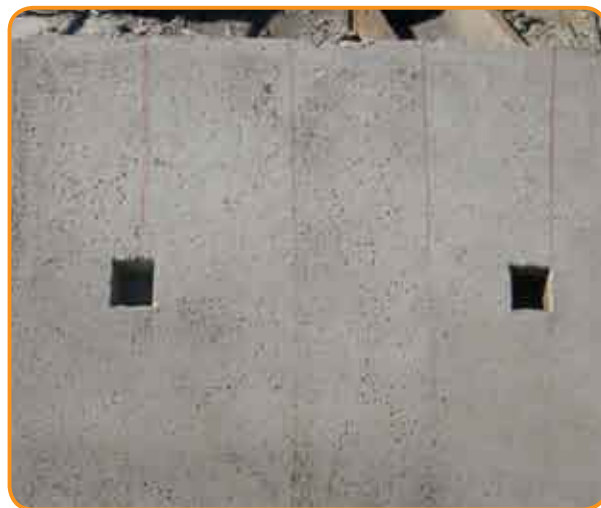
Mesma peça após aplicação, ação e remoção do removedor
