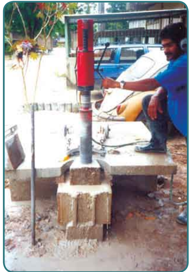
Figura 03 – Detalhe da extração dos testemunhos
