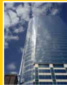
TORRE ALMIRANTE – RIO Prêmio Talento ABECE-GERDAU 2005
