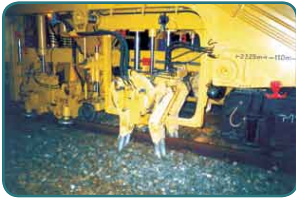
Fig 07 - Visão do equip. nivelador, socador e alin de via
