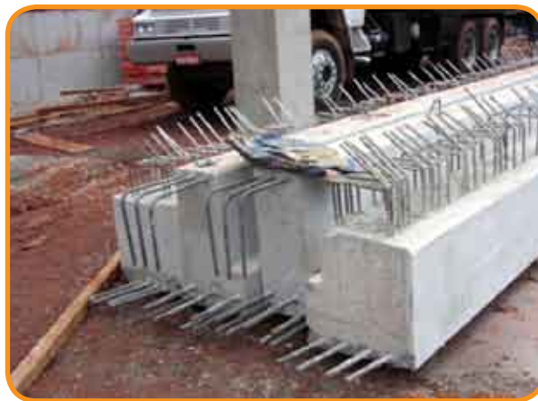
Fig. 3 – Vigas internas e de borda prontas para a montagem. Notar superfícies rugosas para melhorar a aderência.
