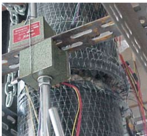
Figura 6 – Detalhe da ruptura - PC01S'0
