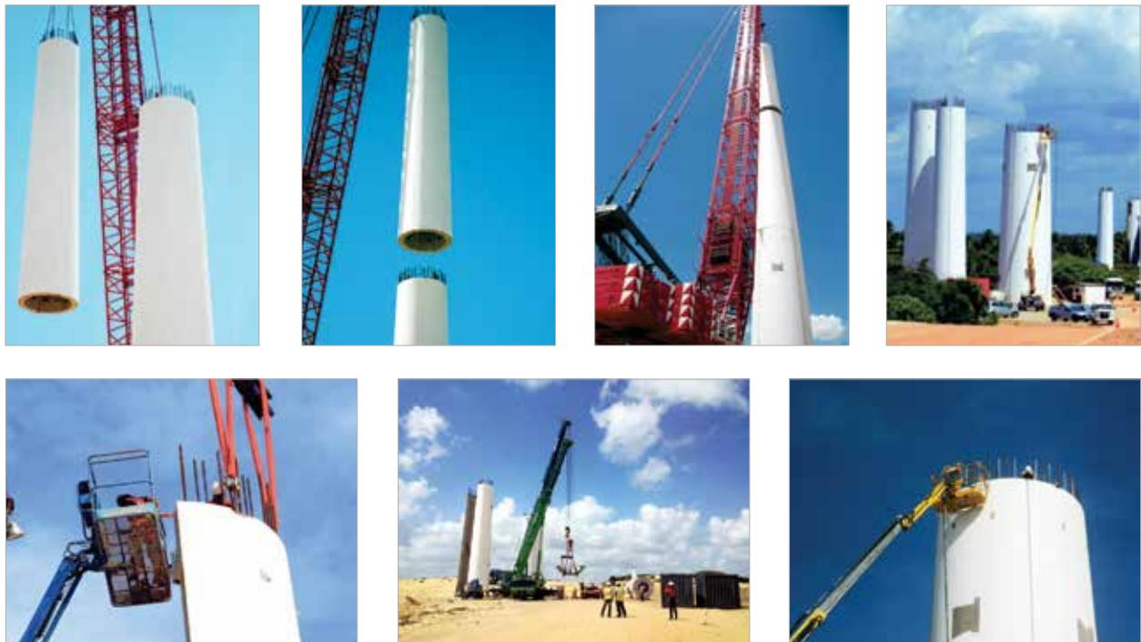
Figura 1 – Imagens da montagem e pré-montagem de torres de concreto pré-fabricado
