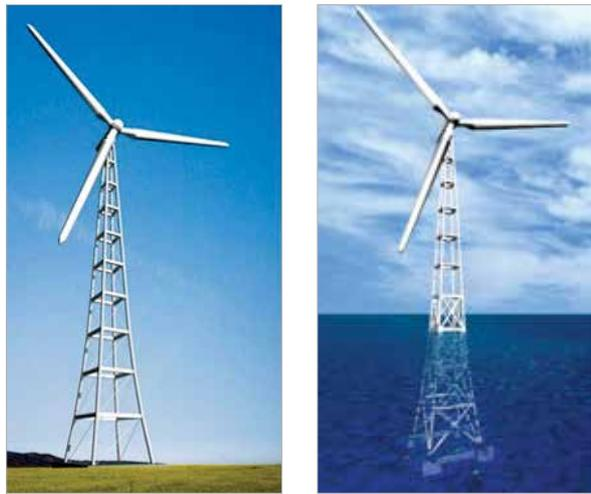
Figura 17 – Torre treliçada pré-moldada em concreto armado desenvolvida pelos autores para *onshore* (à esquerda) e *offshore* (à direita)
