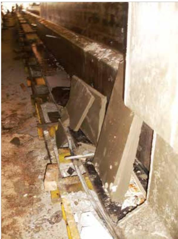
Figura 5 – Vazamento da argamassa do CAA (ALENCAR, 2008)
