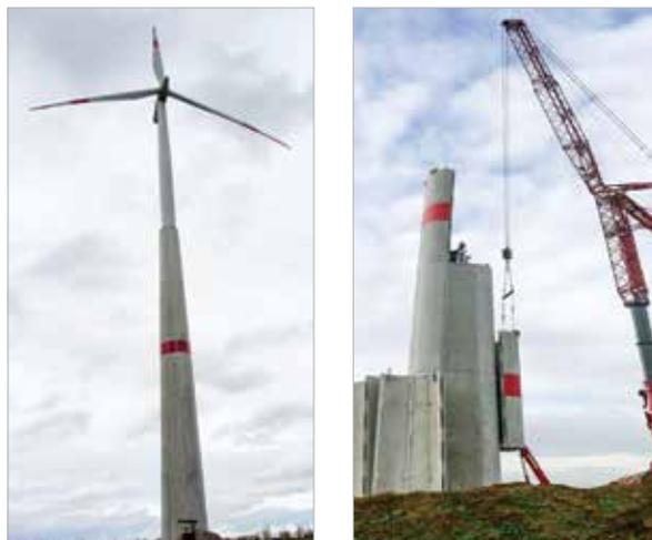
Figura 23 – Solução ATS - torre híbrida em concreto pré-moldado e aço (à esquerda) e montagem (à direita) [10, 11]
