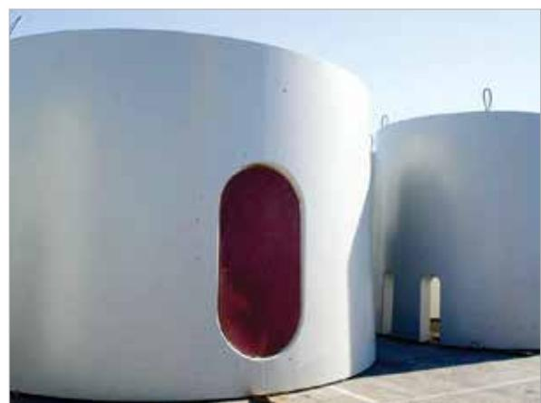
Figura 19 – Anéis pré-moldados de concreto com a porta na base da torre (fonte: Enercon)
