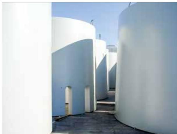
Figura 16 – Torre em concreto pré-moldado para suporte de um aerogerador (à esquerda) (Wikimedia commons); Anéis pré-moldados típicos deste tipo de estrutura (à direita, fonte: ENERCON)
