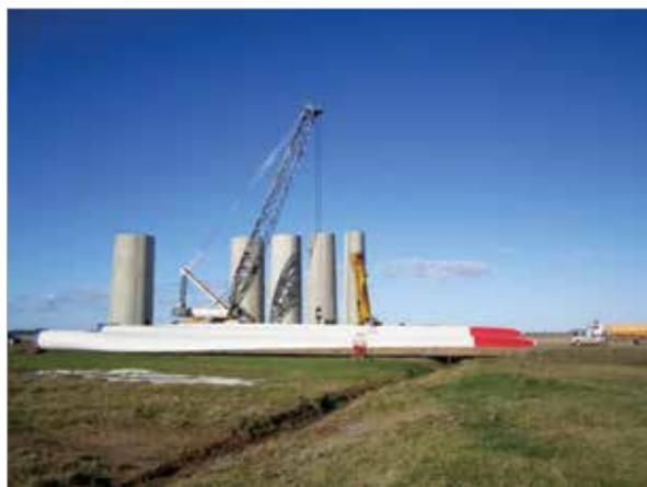
Figura 4 – Peças pré-moldadas com 20 metros de altura, montadas e consolidadas com graute de elevado desempenho
