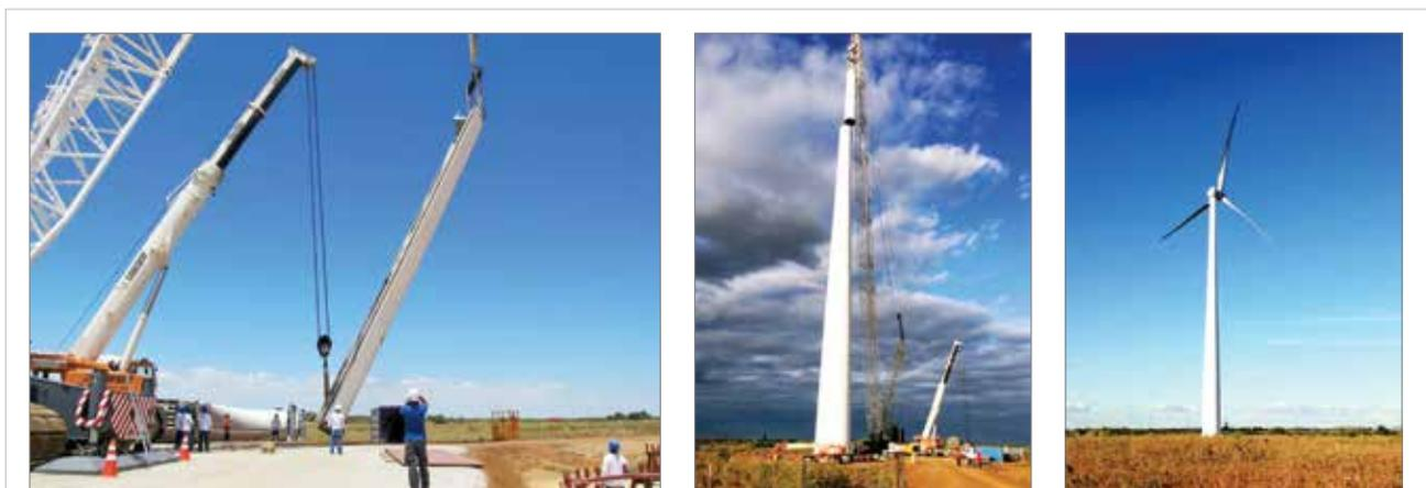
Figura 8 – Visão geral da sequência de montagem do aerogerador
