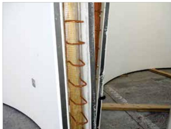
Figura 22 – Detalhe de uma junta vertical
