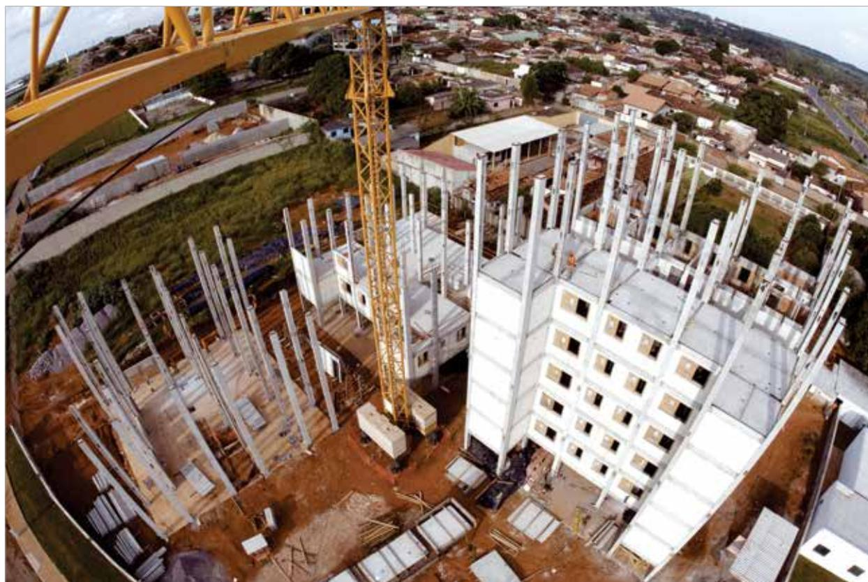
Figura 4 – Edificação construída com estruturas pré-fabricadas de concreto (Fonte: Precon)
