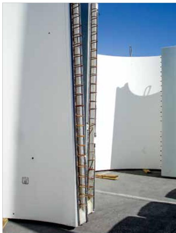
Figura 21 – Anéis semicirculares pré-moldados em concreto na base da torre, com juntas verticais e horizontais
