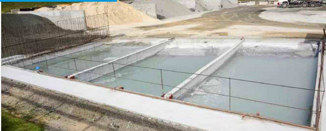
Sistema de tratamento da água usada na lavagem dos caminhões betoneiras
