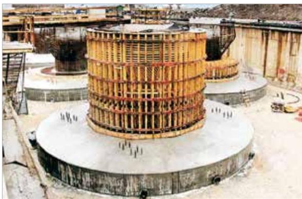
Figura 14 – Fundação de gravidade em concreto pré-moldado para águas pouco profundas. A torre é montada no topo [05]
