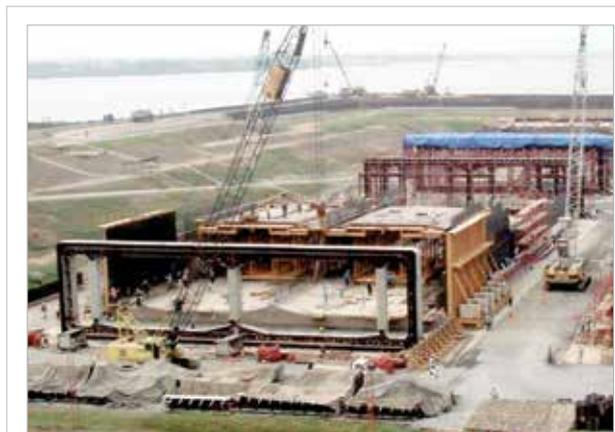
Figura 6 – Construção de elemento de concreto em doca seca
