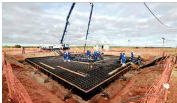
Figura 1 – Vista do início da concretagem de uma base
