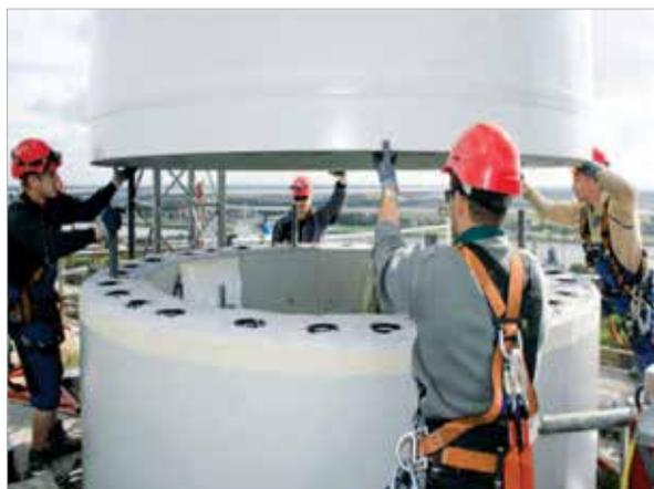
Figura 20 – Ligações horizontais entre dois anéis pré-moldados de concreto (fonte: Enercon)
