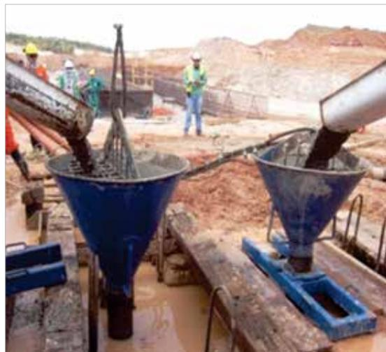
Figuras 38 e 39 – Esquema da montagem das tubulações e painel sendo concretado
