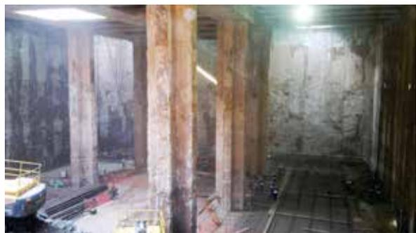
Figura 43 – Aspecto da estrutura concluída, onde se vê linearidade e prumo dos elementos
