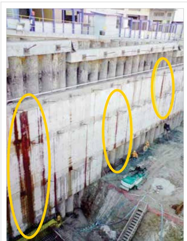
Figura 16 – Fluxo de água atrás da vedação da cabeça do tirante
