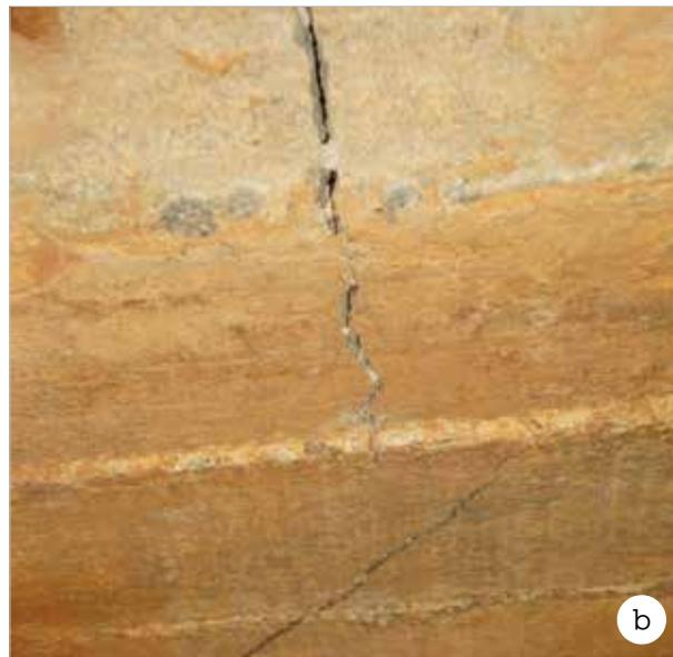
Figura 1 – Fissuração observada no bloco de concreto: a) vista superior; b) vista lateral
