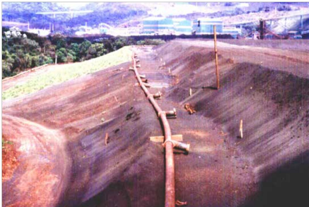
Barragem de rejeitos construída por deposição hidráulica
