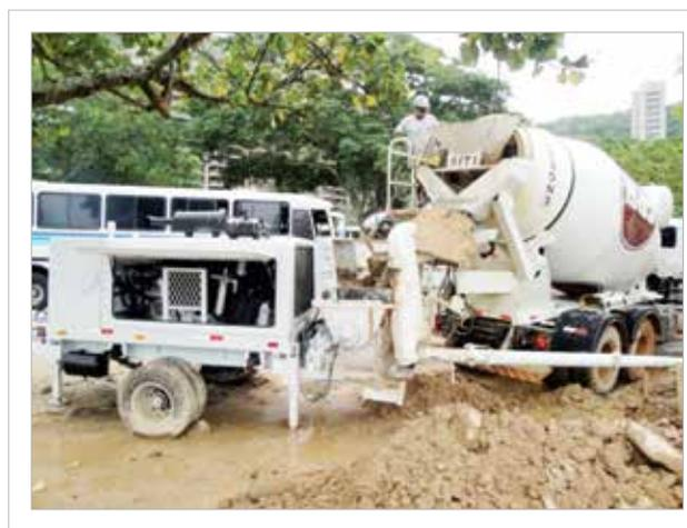
Figura 3 – Bombeamento de argamassa (Local: Parque do Cantagalo, Lagoa Rodrigo de Freitas, RJ)
