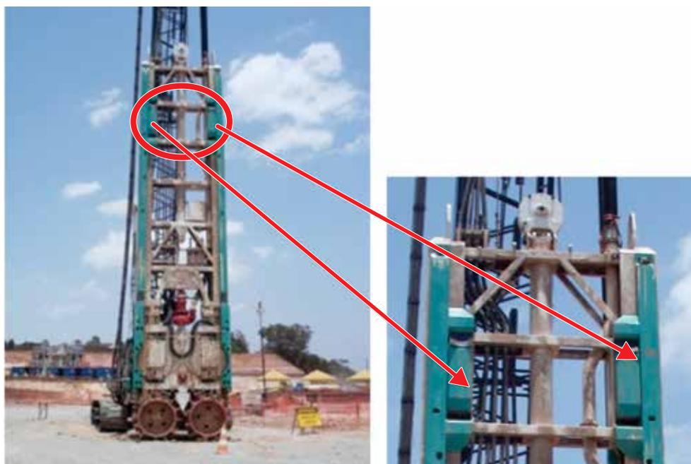
Figuras 21 e 22 – Imagem geral e detalhe dos dispositivos de escoramentos e retomada de prumo
