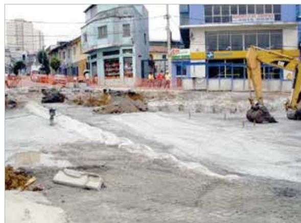
Figura 4 – Reaterro sobre laje da estação na região da Bom Pastor com Greenfeld; vista para norte
