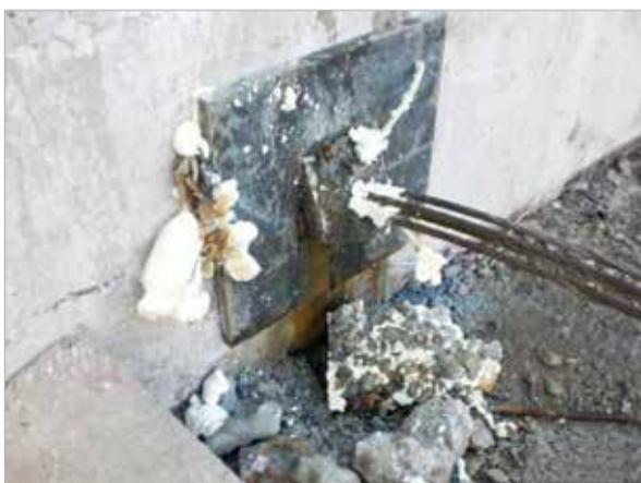
Figura 14 – Cabeça de tirante tratada com espuma expansiva de poliuretano
