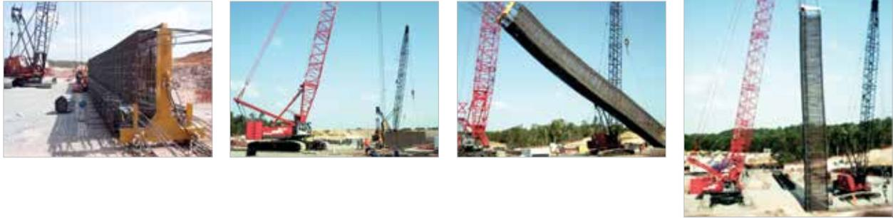
Figuras 34, 35, 36 e 37 – Balancim especial montado, esquema do içamento e gaiola verticalizada
