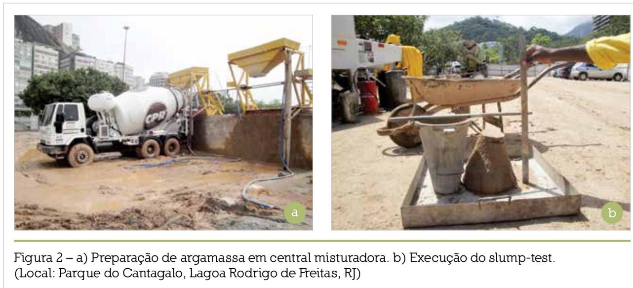
Figura 2 – a) Preparação de argamassa em central misturadora. b) Execução do slump-test. (Local: Parque do Cantagalo, Lagoa Rodrigo de Freitas, RJ)
