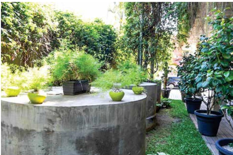
Figura 4 – Cisternas feitas em anéis de concreto no pavimento térreo armazenam a água captada na chuva e no telhado verde para reaproveitamento no sistema
