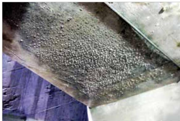
Figura 9 – Gotejamento devido à inversão térmica
