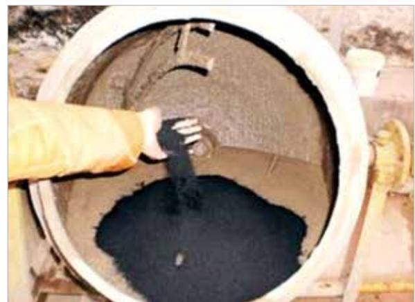
Figura 12 – Adição da borracha de pneu à argamassa de areia e cimento
