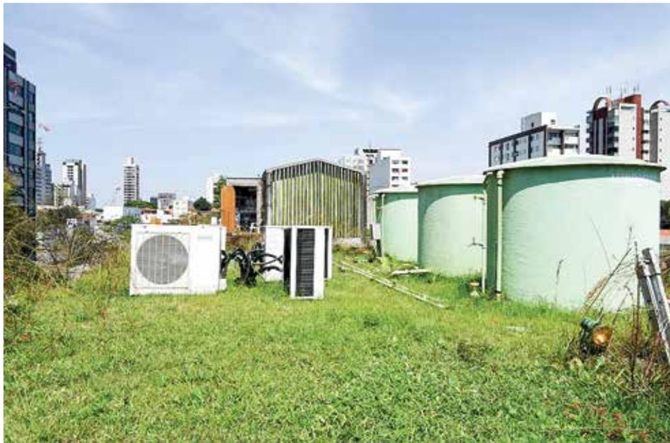
Figura 5 – Caixas elevadas posicionadas na laje distribuem água por todo o sistema
