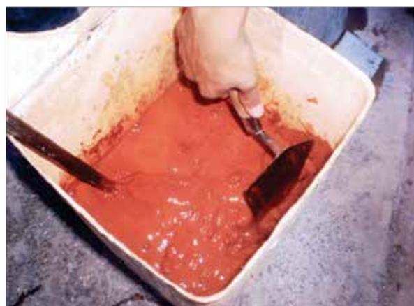
Figura 5 – Dissolução do pó cerâmico em uma parte da água de amassamento
