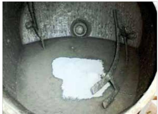
Figura 11 – Adição do pó de pedra à argamassa de areia e cimento
