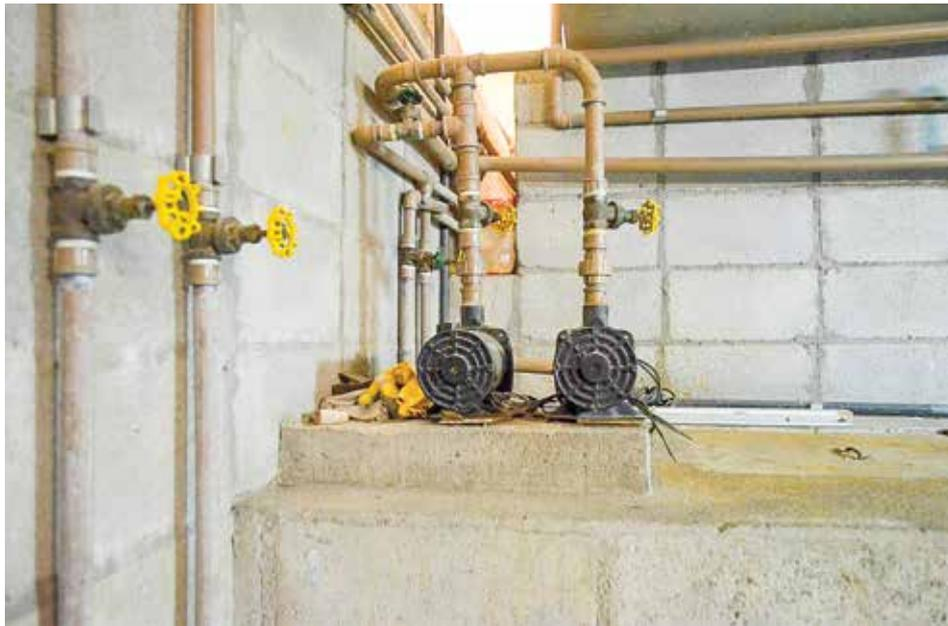
Figura 8 – Sistema de bombeamento conduz água do reservatório subterrâneo para as caixas elevadas (E)
