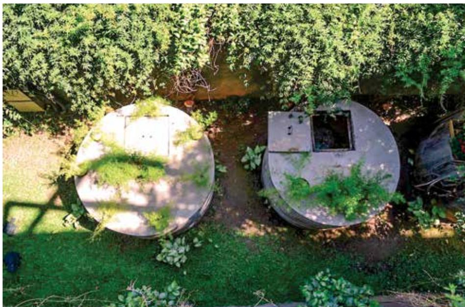
Figura 9 – Cisternas recebem excedente de água do telhado verde (G)
