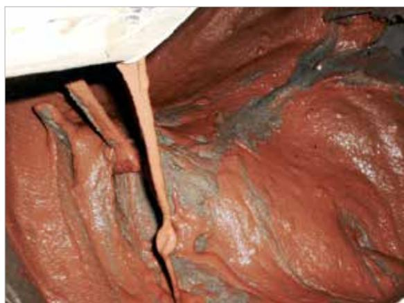
Figura 7 – Adição do pó cerâmico dissolvido à argamassa de areia e cimento
