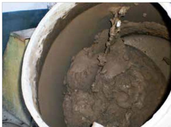
Figura 6 – Preparação da argamassa com cimento e areia
