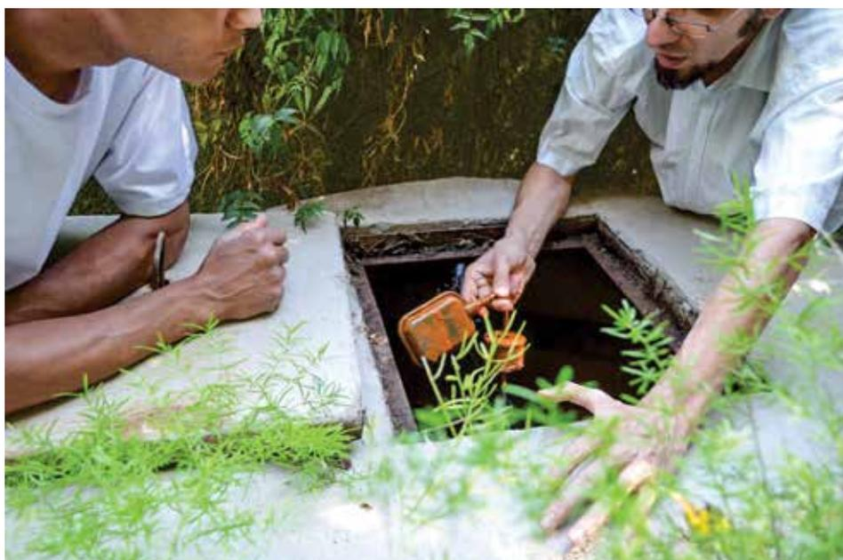
Figura 7 – Cisterna 3 - Nível de água é controlado com boia elétrica (C)
