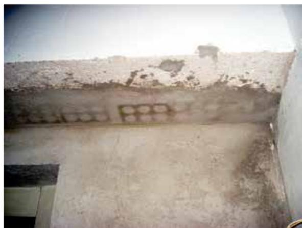
Figura 4 – Preenchimento com blocos cerâmicos
