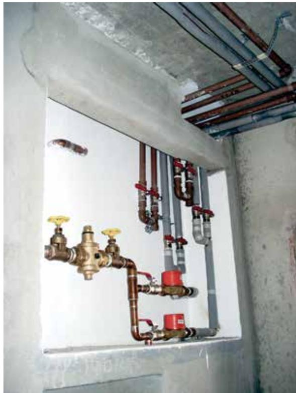
Figura 7 – Solução adotada para instalação de registros
