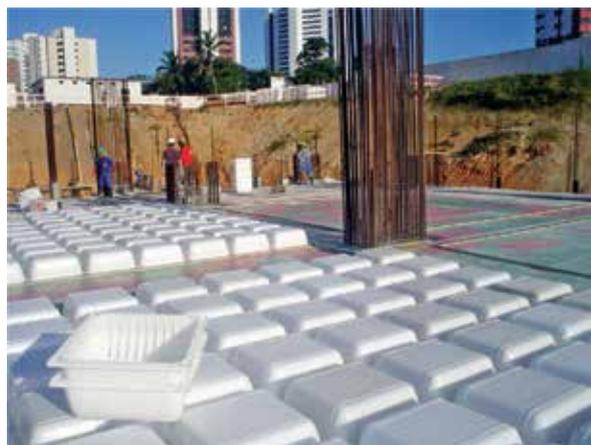
Figura 2 – Detalhes das caixas plásticas
