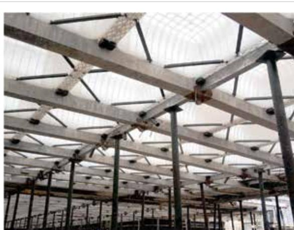
Figura 17 – Vista Inferior do cimbramento metálico com as fôrmas plásticas para laje nervurada
