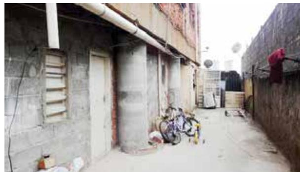
Figura 7 – A continuação do reforço nos pilares localizados no térreo do Edifício União
