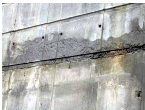
Figura 2 – Segregação do concreto na base da parede na ligação entre pavimentos – Obra 2
