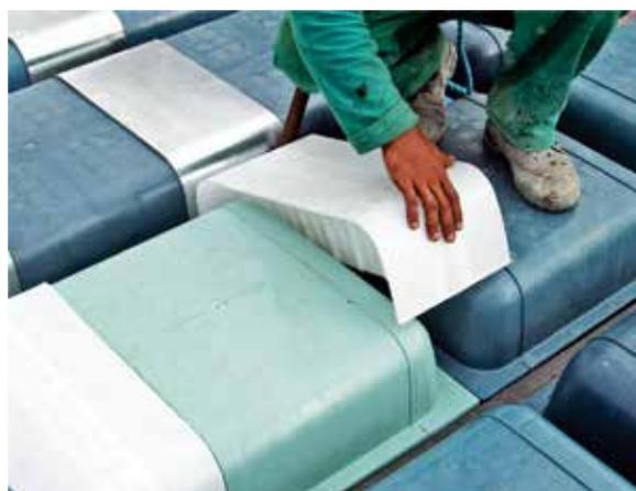
Figura 6 – Detalhe de tapa nervura para lajes unidirecionais
