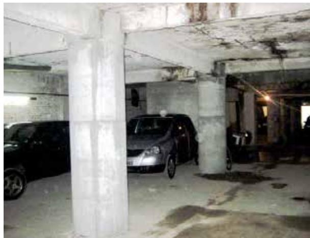
Figura 6 – Pilares reforçados localizados no subsolo do Edifício União
