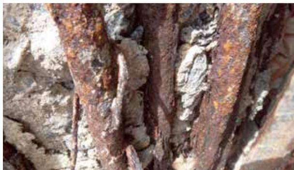
Figura 4 – Detalhe do grau de corrosão das armaduras longitudinais dos pilares cilíndricos, localizados no térreo do Edifício União
