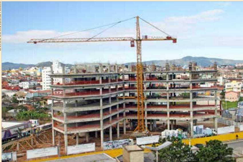
as armaduras complementares para as vigas e lajes e inicia-se a última etapa de concretagem, que pode ser feita de duas maneiras: primeiro é concretada a camada inicial de 15 cm e depois o capeamento de 5cm, ou executa-se uma concretagem única, onde viga e capa são cobertas em uma só operação. É importante destacar que as peças possuíam comprimento máximo de 8 metros e, por esta razão, o transporte com caminhões “trucks” foi realizado sem dificuldades, mesmo dentro de um centro urbano.
