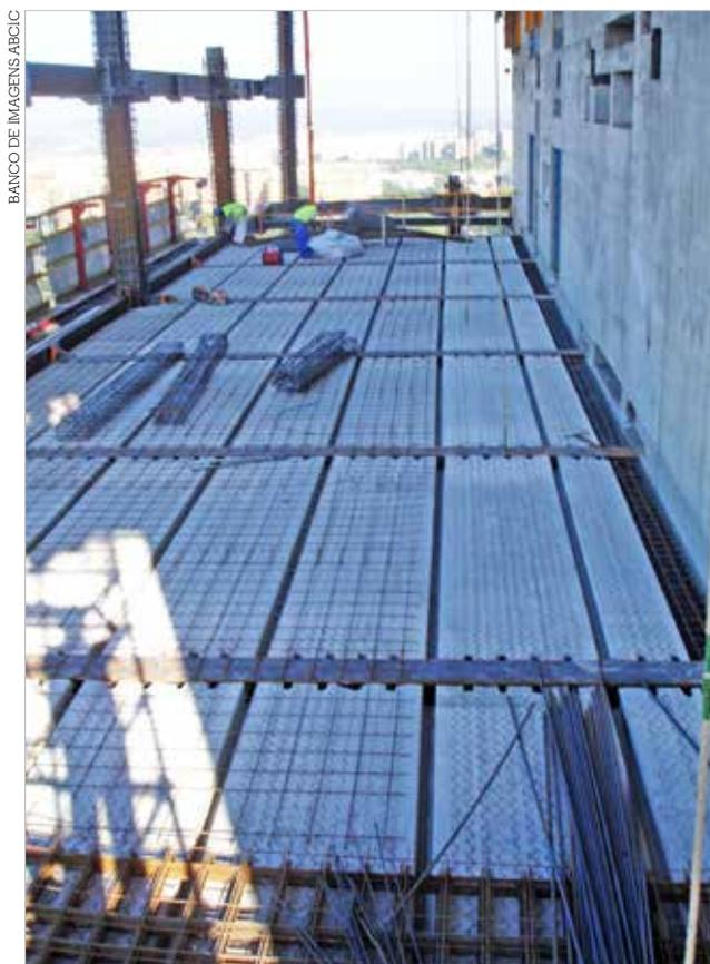
Com 250m de altura, o Edifício Torre de Cristal em Madrid usou tajes alveolares pré-fabricadas e pilares compostos de concreto com perfis metálicos em seu interior
