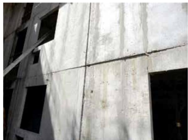
Figura 5 – Ressalto na ligação entre pavimentos – Obra 5
