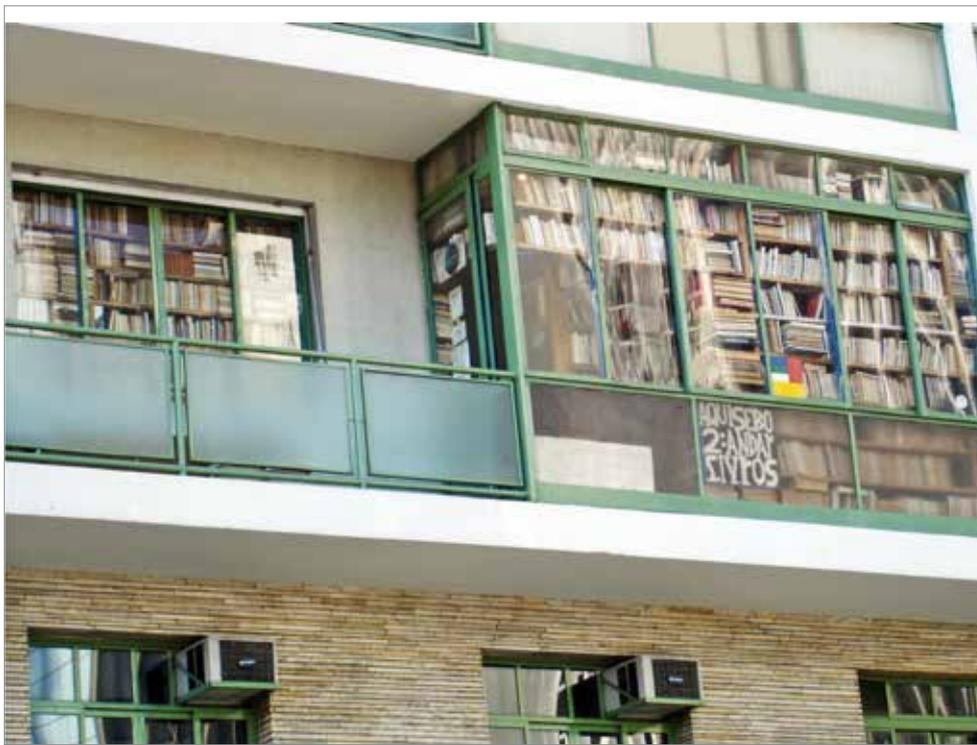
Foto 5 - Uso inadequado provocando sobrecarga não prevista - Fase U do PPEU
