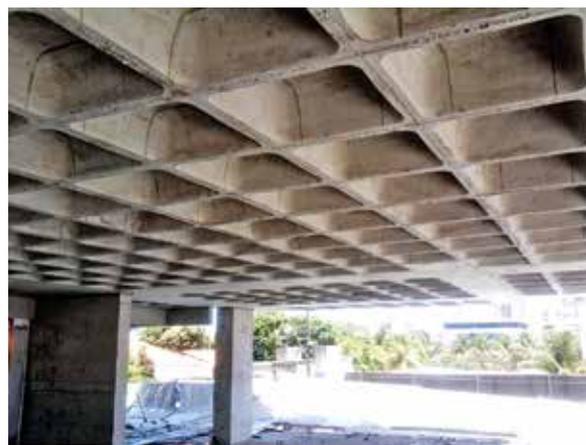
Figura 3 – Vista inferior da laje nervurada
