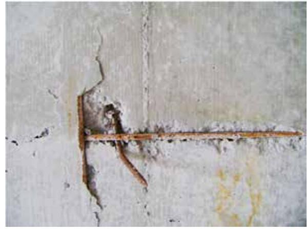
Figura 4 – Armadura exposta – Obra 3
