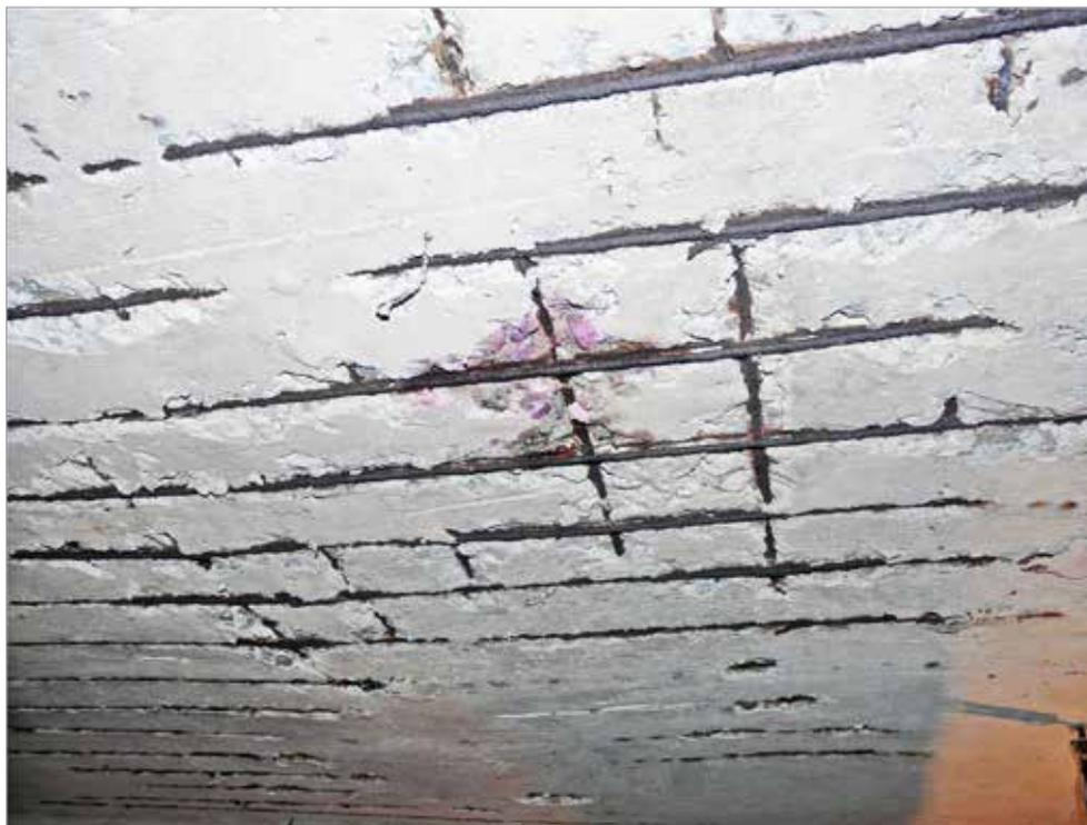
Foto 2 – Deficiência de cobertura em laje de concreto – Fase E do PPEEU
