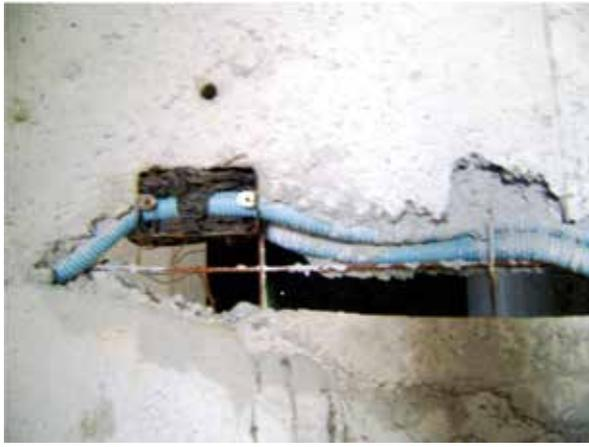
Figura 3 – Falha de concretagem na parede sob eletroduto – Obra 3
