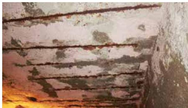
Figura 3 – Corrosão nas armaduras das vigas e lajes do subsolo
