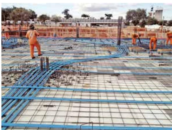
Figura 5 – Fôrma para laje maciça utilizando forma plástica plana
