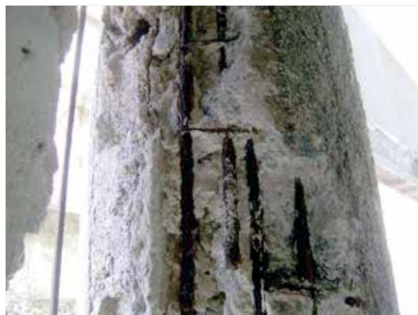
Figura 2 – Corrosão nas armaduras dos pilares do subsolo e térreo, respectivamente
