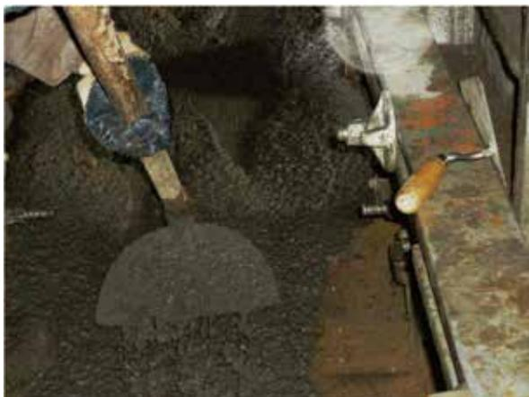
Figura 1 – Vazamento de concreto na base da fôrma – Obra 1
