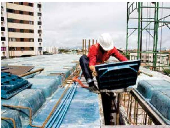
Figura 15 – Montagem da fôrma plástica plana
