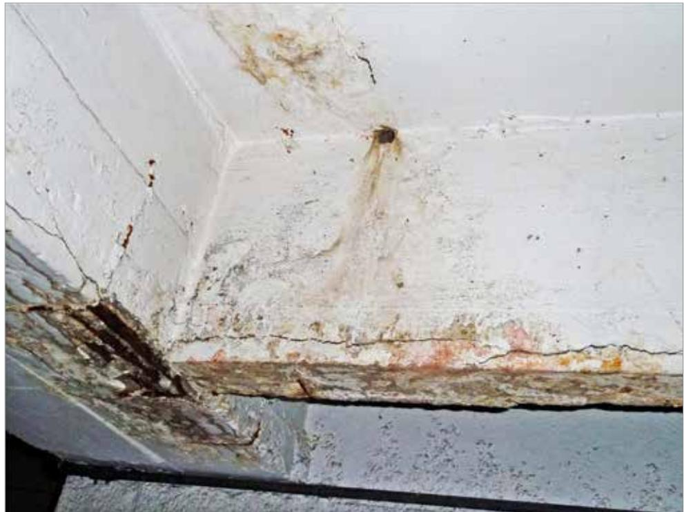
Foto 3 – Deficiência de manutenção em laje de concreto, agravada devido infiltração – Fase U do PPEEU
