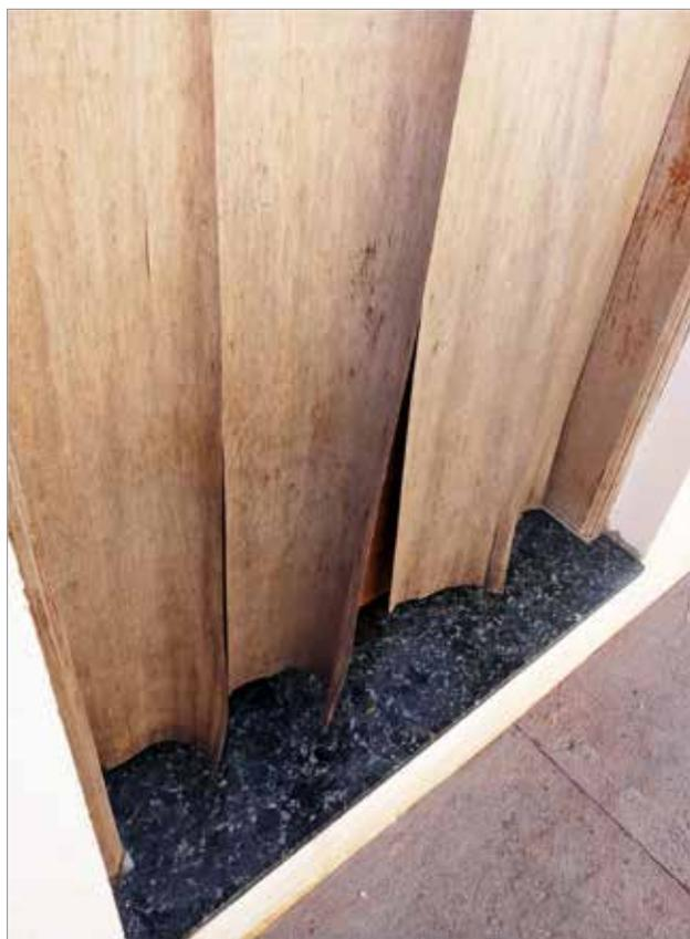
Foto 4 – Deficiência de especificação de porta não indicada para ambiente externo sujeito às intempéries: Deveria ser em madeira maciça e não folheada – Fase P do PPEU
