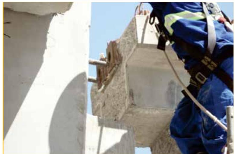
Figura 10 – Detalhe da ligação das lajes
