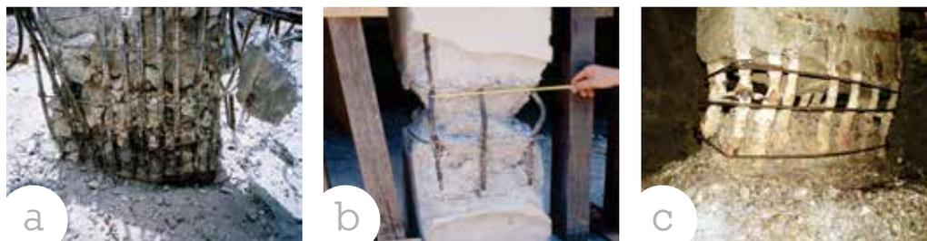
a) e c) devido à má execução (bicheiras) e b) devido a erro de projeto (dimensionamento insuficiente). Na esmagadora maioria das vezes, a resistência à compressão efetiva do concreto na obra é inferior à do concreto medida no corpo de prova de referência. O corpo de prova de controle mede a resistência potencial do concreto na “boca da betoneira”, sob condições ideais de adensamento, cura e ensaio (acervo PhD Engenharia)
