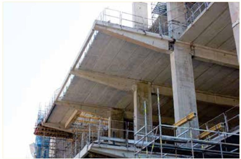
Figura 9 – Detalhe da montagem dos balanços
