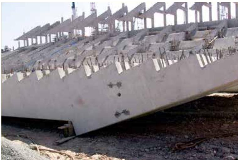
Já os degraus se interligam pontualmente uns com os outros e se apoiam nas vigas jacarés.
