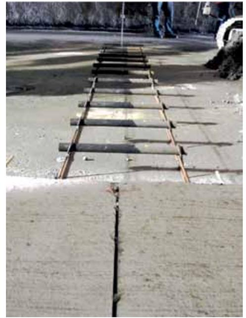
Figura 11 – Sistema de apoio das barras de transferência
