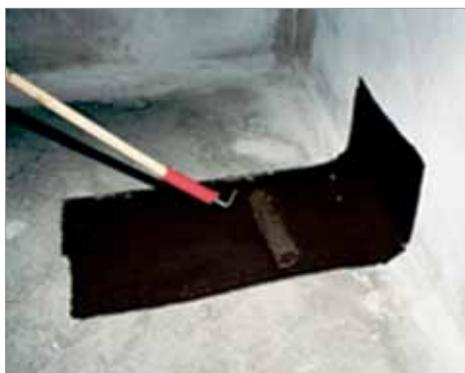
Figura 4 – Aquecimento simultâneo com chama de maçarico do piso com o primer e a manta, avançando o rolo com o pé
