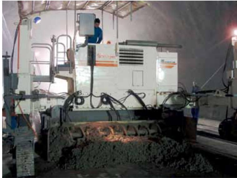
Figura 12 – Colocação das barras de transferência sobre o CCR
