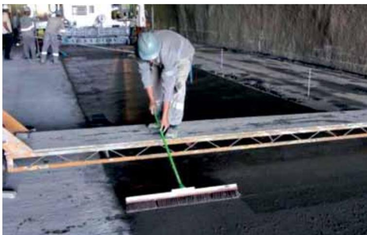
Figura 16 – Aplicação do produto de cura sobre a superfície acabada do concreto
