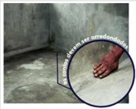
Figura 3 – Aplicação de uma demão de primer, em toda a área do piso e nos rodapés, na altura adequada a cada caso. Aguardar secagem.
