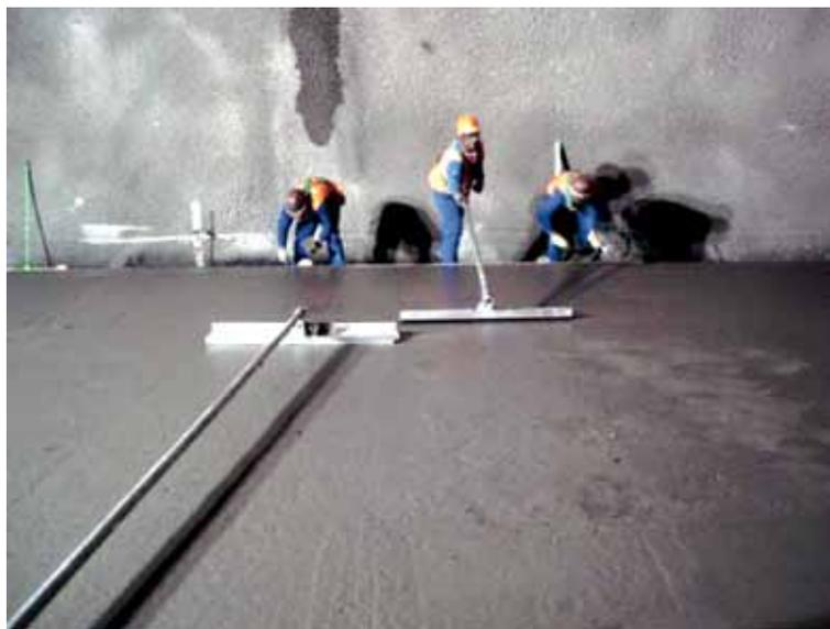
Figura 15 – Texturização longitudinal da superfície do concreto com vassoura de piaçava
