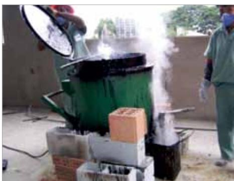
Figura 11 – Aplicações da manta asfáltica com asfalto quente
