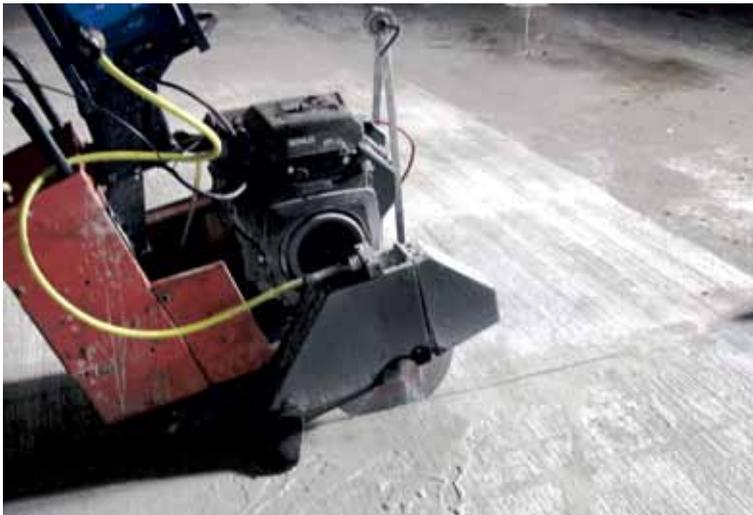
Figura 18 – Janela de corte teórica para corte das juntas transversais
