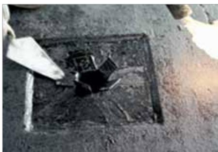
Figura 6 – Ilustração da execução de proteção mecânica de transição com camada separadora, após realização do teste de estanqueidade
