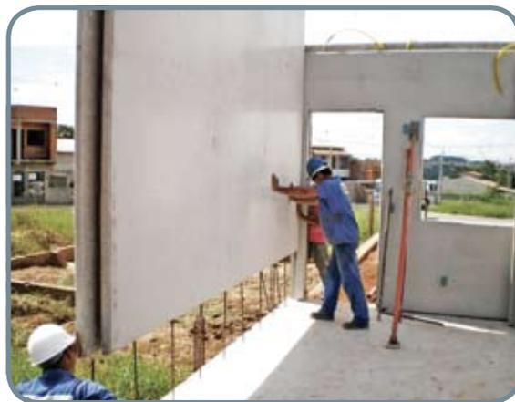
*Sistema com adoção de paredes duplas, durante a montagem*
