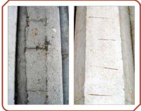
mas, uma vez que a oxidação dessa armadura pode provocar, com o passar do tempo, a ruptura localizada do concreto que cobre essa armadura, reduzindo assim a seção útil a ser considerada dessas estacas. A Figura 12 ilustra tal tipo de fissuras e/ou trincas.
