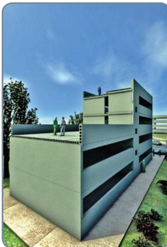
*Sistema em pré-fabricado com adoção de painel maciço e painel alveolar*
