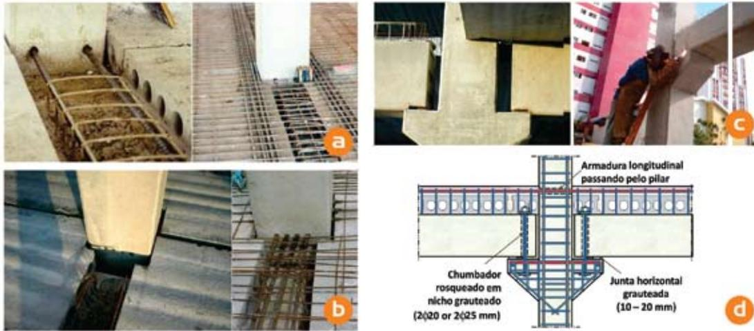
res dentro de bainhas grauteadas ou por meio de acopladores rosqueados, conforme Figuras 1a e 1b. Para o caso das conexões positivas, são empregadas soluções por meio de chapas soldadas, conforme Figura 1c. Para momentos de menor intensidade, um segundo detalhamento emprega chumbadores parafusados e grauteados para prover um efeito de pino na ligação, conforme Figura 1d.
