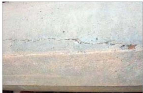
Figura 4 – Fissuras longitudinais em estacas em processo de cravação
