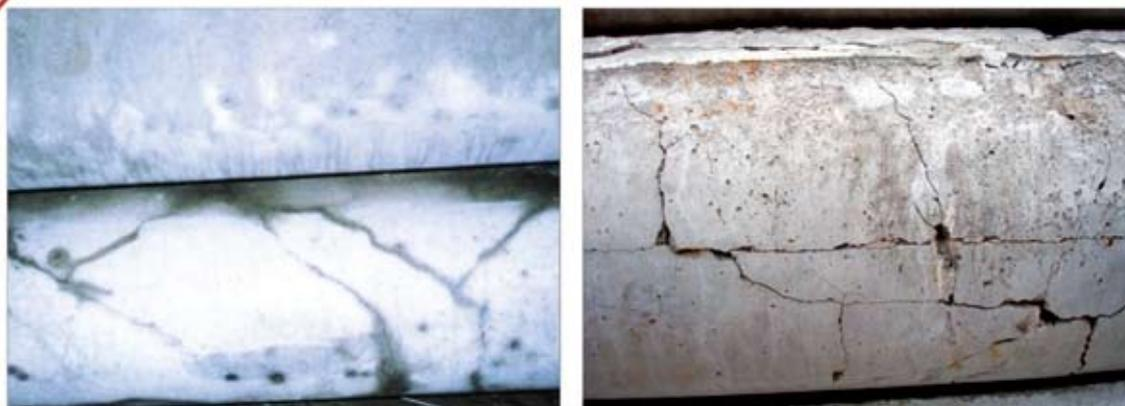
Figura 11 – Fissuras e/ou trincas de retração
