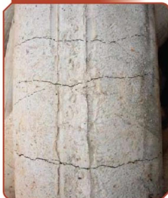
Figura 6 – Trincas transversais concentradas
