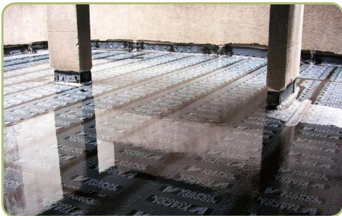
*Figura 3 - Manta asfáltica aplicada em laje*
