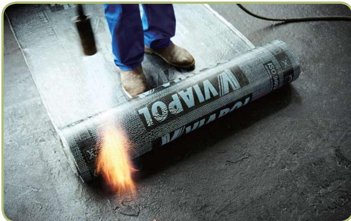
*Figura 1 - Aplicação de manta asfáltica com maçarico em laje*
