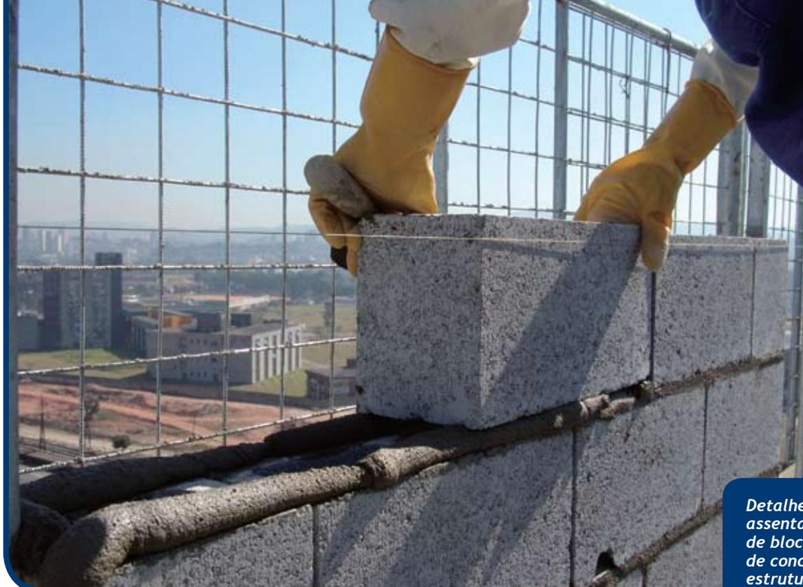
*Detalhe do assentamento de blocos de concreto estruturais*
