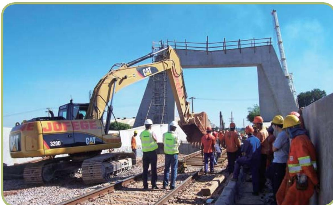
**Figura 2 - Etapa do processo construtivo do Viaduto Ferroviário sobre a Rodovia SP 330, que usou manta asfáltica na impermeabilização do tabuleiro**
