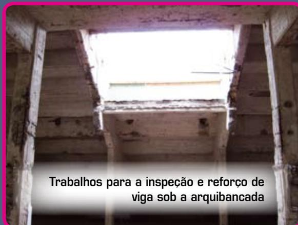
Trabalhos para a inspeção e reforço de viga sob a arquibancada
