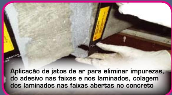
Aplicação de jatos de ar para eliminar impurezas, do adesivo nas faixas e nos laminados, colagem dos laminados nas faixas abertas no concreto
