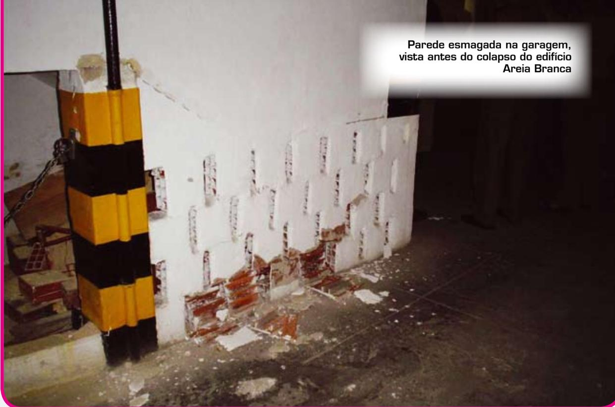
Parede esmagada na garagem, vista antes do colapso do edifício Areia Branca
