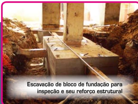
Escavação de bloco de fundação para inspeção e seu reforço estrutural
