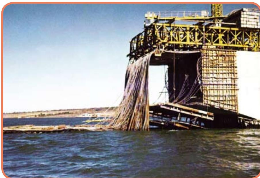
**Fig. 3** – Aspecto dos cabos pendentes e mergulhados no lago depois da forte ventania de julho de 1970. A fôrma inferior já estava sendo posicionada para execução da 3ª aduela. Os flutuadores estão vazios, sem os cabos que caíram n' água durante o vendaval.
