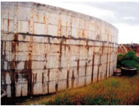
Foto 9 – Tirada em 29 de março de 2008. Selamento de praticamente todos os vazamentos por fissuras
