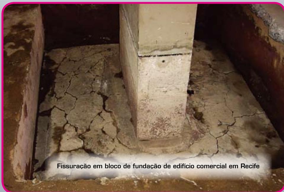
Fissuração em bloco de fundação de edifício comercial em Recife
