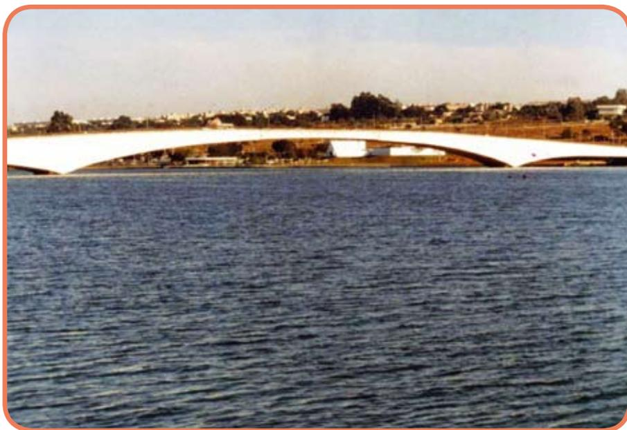
Fig. 8 – Vista lateral de 1991 da ponte terminada. Observe-se que a pintura da parte metálica central, com epóxi de cor branca fosca, disfarça completamente o uso do aço.
