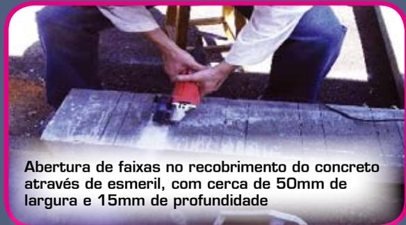
Abertura de faixas no recobrimento do concreto através de esmeril, com cerca de 50mm de largura e 15mm de profundidade
