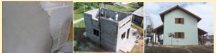
Figura 04: Etapas de produção do protótipo com o aproveitamento das cinzas pesadas.
