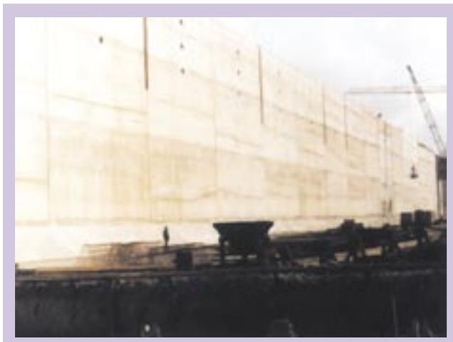
Uma das maiores obras do mundo de concreto preparado com agregados reciclados foi construída na Bélgica, entre 1981 e 1988, a Eclusa de Berendrecht, para ampliação do porto de Antuérpia.
