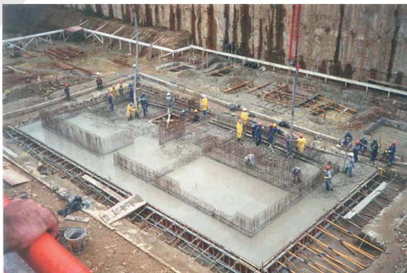
Fundação do Edifício e-Tower - Concreto Refrigerado
