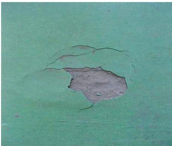
Figura 1.1: Destacamento da camada de revestimento, em contato com substrato [Fonte: Foto da autora, 2003].
