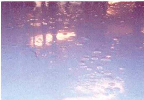
Figura 1.3: Ocorrência de bolhas no revestimento devido à presença de umidade no substrato quando da sua aplicação (Fonte: Foto cedida pelo centro tecnológico de controle de qualidade L. A. Falcão Bauer, 2003).
