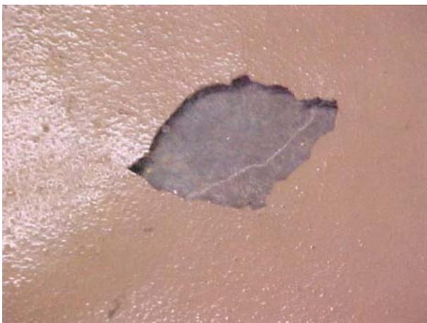
Figura 1.2: Destacamento do revestimento de pequena espessura, à base de resina epóxi (Fonte: PCA, 2000).
