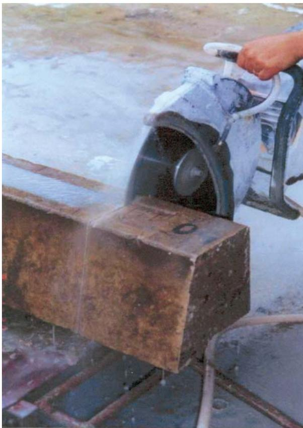
Figura 1 - Detalhe do corte dos dormentes
