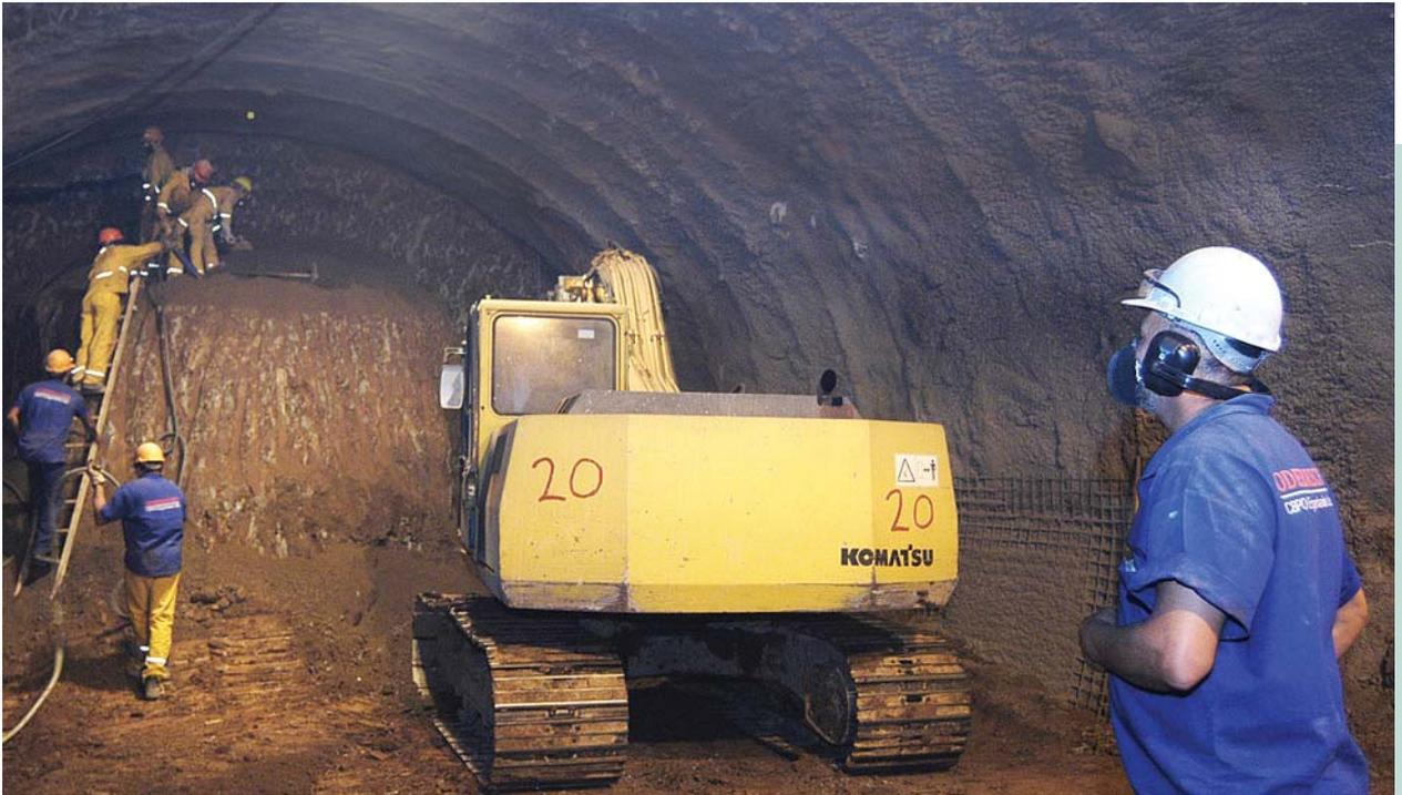
Sistema NATM na execução de túnel
