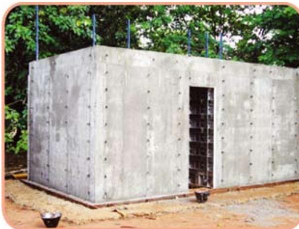
Protótipo de casa usando paredes de concreto
