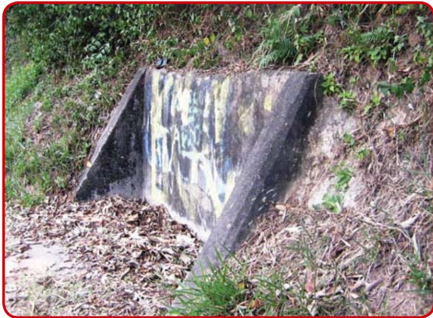
Pequeno muro de concreto armado com contrafortes
