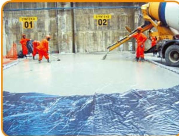
Figura 6 – Piso concretado e polido
