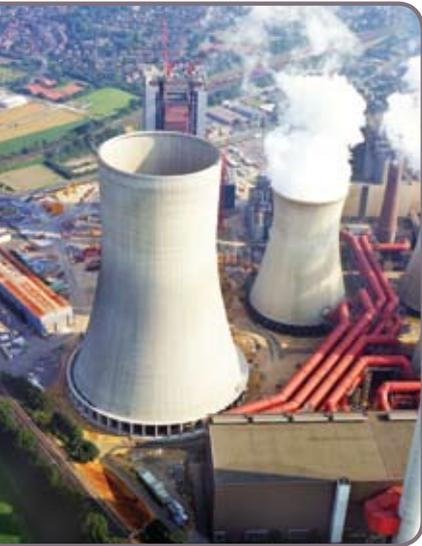
A Torre de Resfriamento de Niederaussem, na Alemanha, a mais alta (200m) e mais larga (136m de diâmetro de base) do mundo, destaca-se, principalmente, pelo tipo de concreto usado em sua construção. Denominado tecnicamente como HPC-SRB 85/35, este concreto caracteriza-se por seu alto nível de resistência contra o ácido sulfúrico e outros gases ácidos lançados pela Torre.
