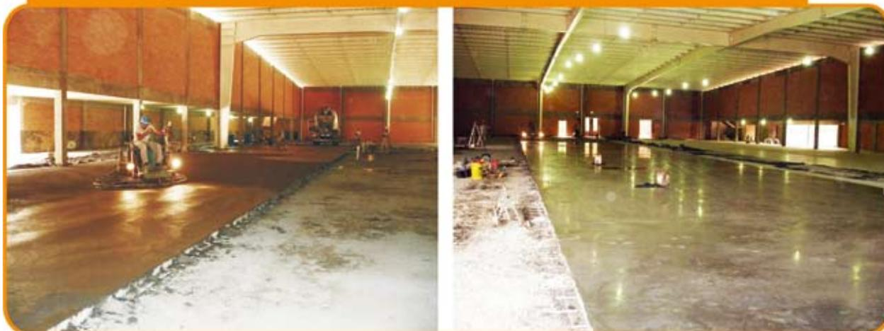
Estruturalmente, o impacto do aparecimento de fibras na superfície é nulo, uma vez que a quantidade de fibras envolvidas em um metro cúbico de concreto (dosado com 20 quilos, por exemplo) pode chegar a cerca de 90.000 peças; e as poucas fibras que, porventura, aflorarem não comprometerão a qualidade estrutural do mesmo.
