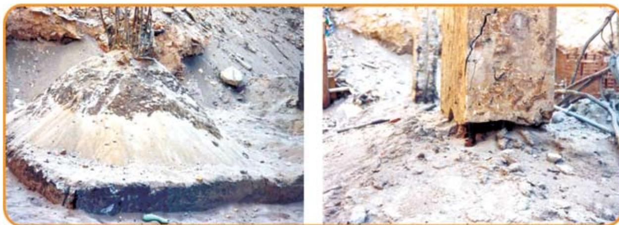
Fotos 3 e 4 – Edifício Areia Branca: sapatas e ligação pilar/sapata
