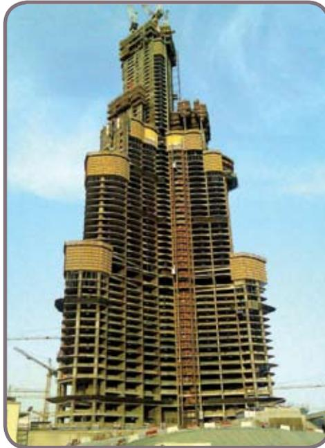
é obtida por meio de shear walls de 60 cm, feitas de concreto armado, em torno de um hexágono central feito do mesmo material, além dos 27 setbacks criados pela interceptação das bays nos wings. A solução objetivou resolver os conflitos entre os parâmetros da estrutura e os de funcionalidade para um edifício residencial alto.
