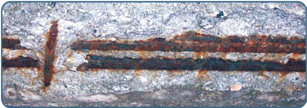
Figura 7 – Armadura com corrosão generalizada
