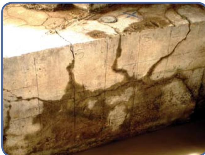
Figura 6 – Bloco de fundação com a vida-útil já comprometida pela RAA
