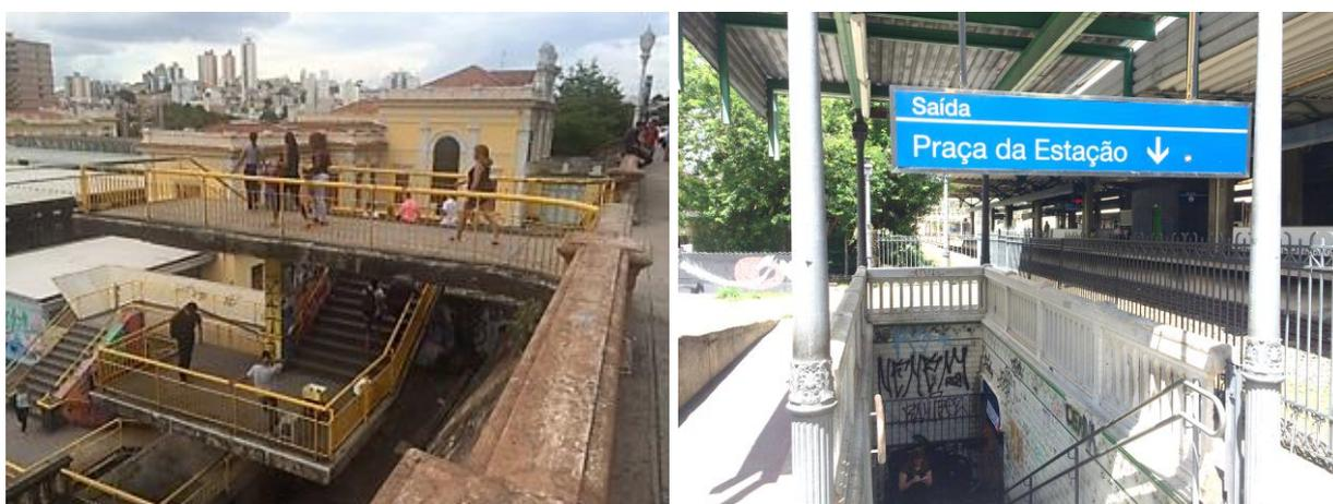
Figura 1. Escada de acesso da Rua Sapucaí (**largura = 4,45m**) ao túnel de acesso à Praça da Estação/Metrô – **desnível entre a Rua Sapucaí e a entrada do túnel = 10,77m; desnível da escada de acesso ao túnel = 3,80m.**
