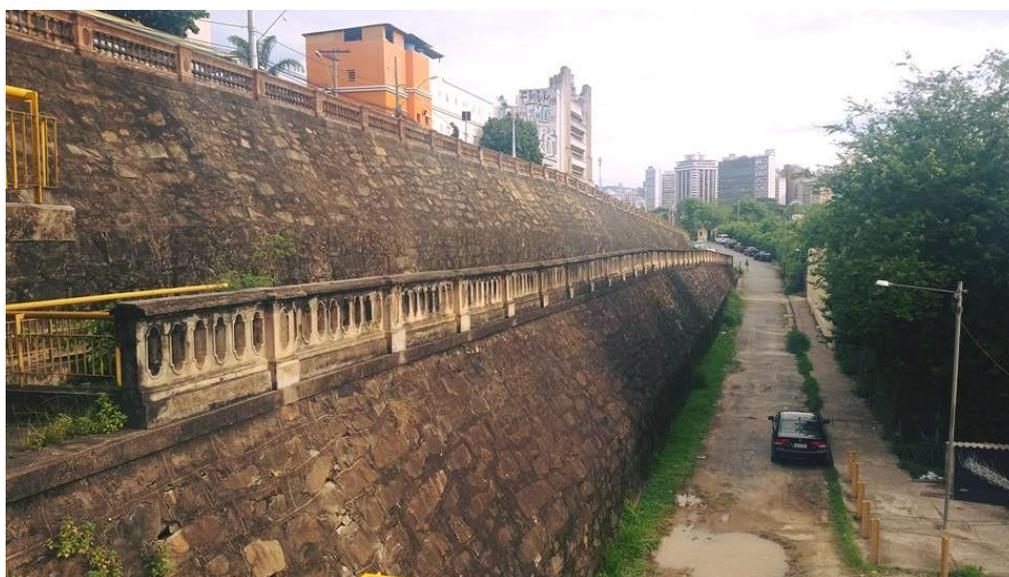
Figura 2. Detalhe do muro de arrimo e balaustrada da Rua Sapucaí.
