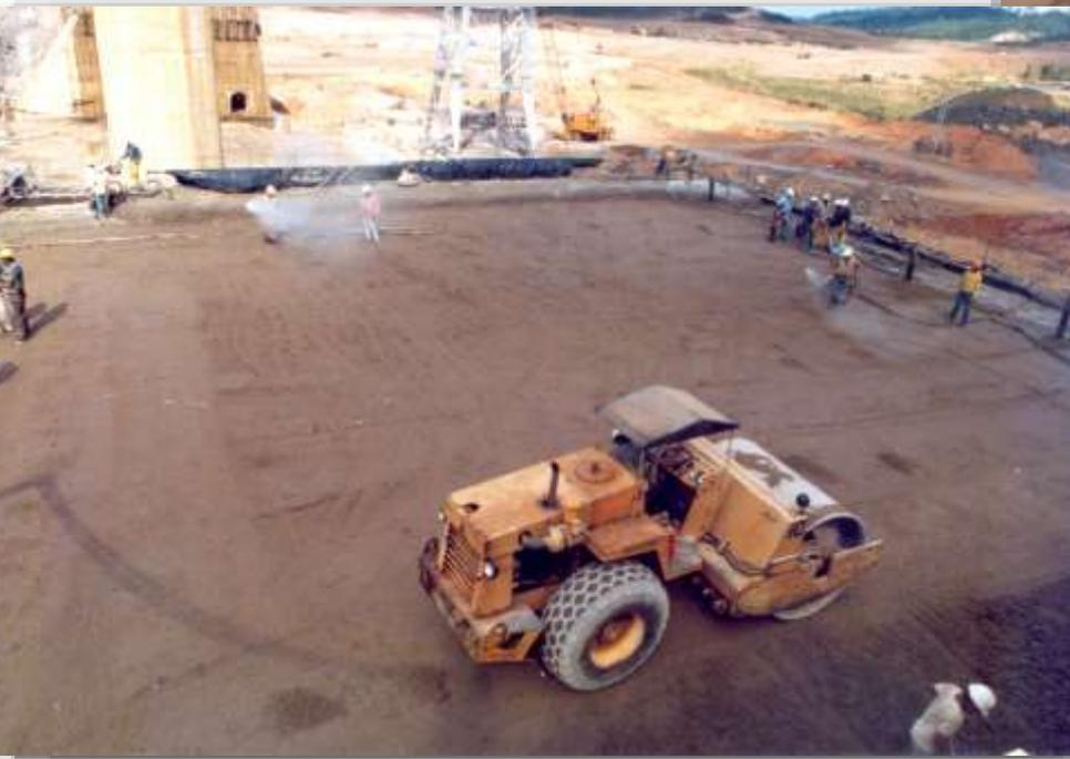
**Compactação** do CCR no Bloco 1A1, através de rolos vibratórios auto propelidos CA25-D.
