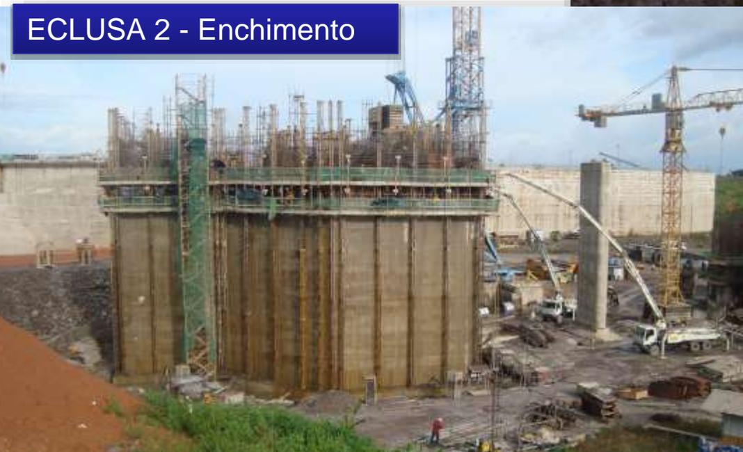
**Concretagem** com forma deslizante no Bloco de Enchimento.
