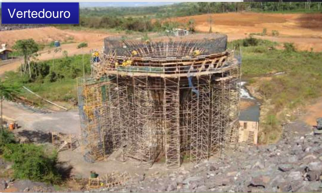
Armação, montagem de formas e concretagem da Camada 10, el. 32,77 a 34,27m.
