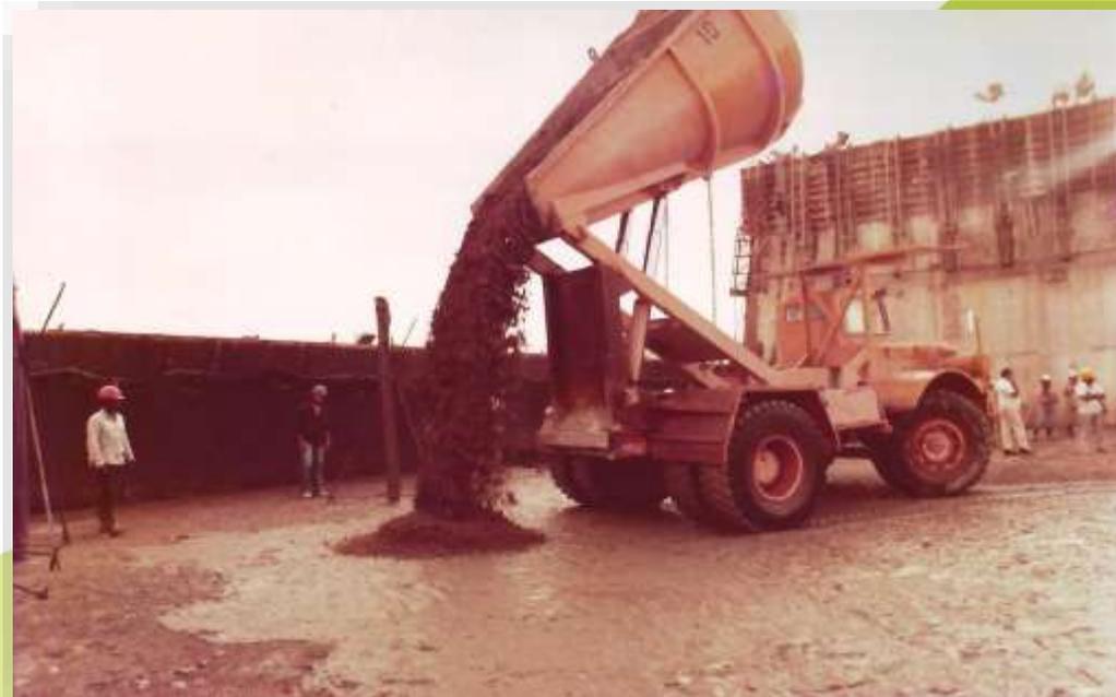
Transporte e descarregamento do CCR no Bloco 1A1, com a utilização de um caminhão basculante RK-424.
