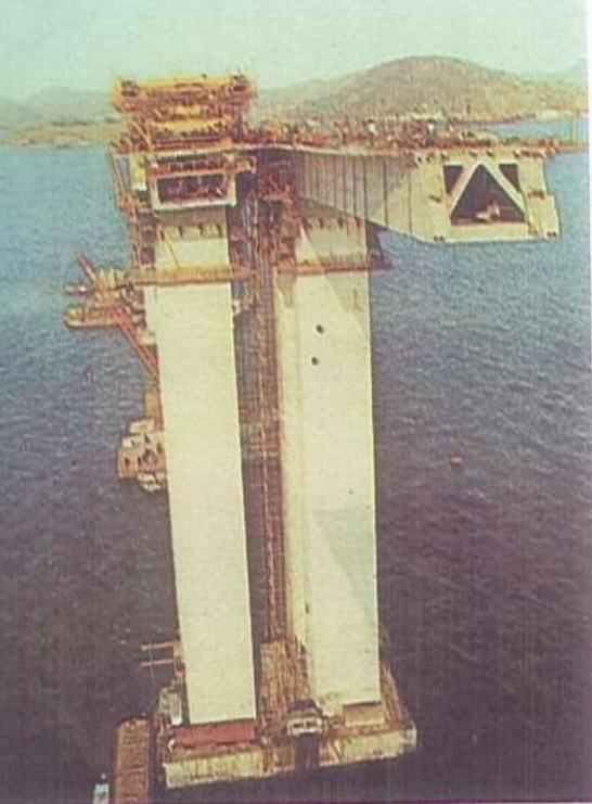
*Foto 8.5.5. Vista frontal do escoramento de montagem, no pilar 103 lado Paquetá.*
