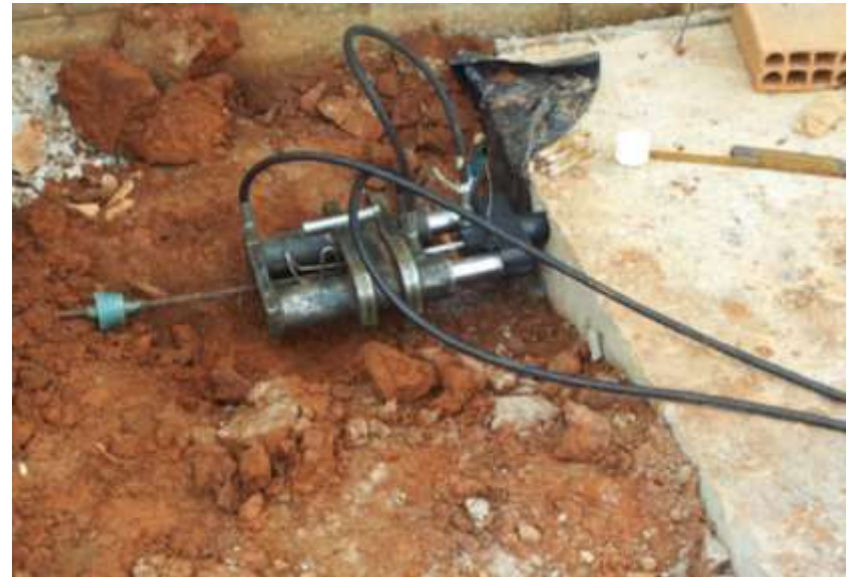
Figura 06 – Pós-Tração Não Aderente
