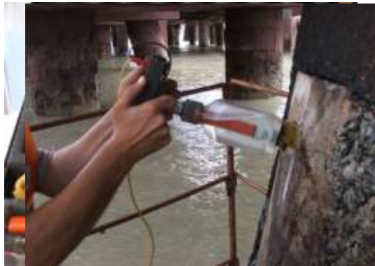
Potencial de corrosão
