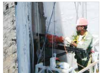
▶ Figura 11 Perfuração de furo de alívio
