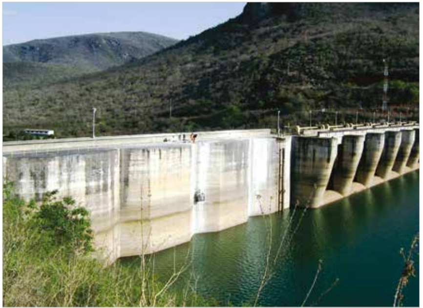
► Figura 6 Vista de montante dos blocos da ombreira esquerda
