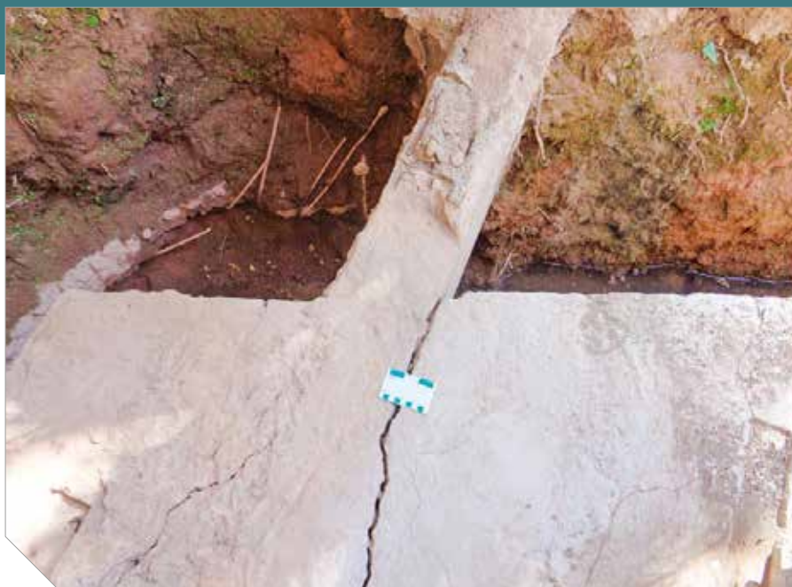
Bloco de fundações afetado por RAA de edifício em São Paulo
