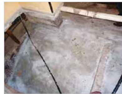
► Figura 17 Sapata concretada
