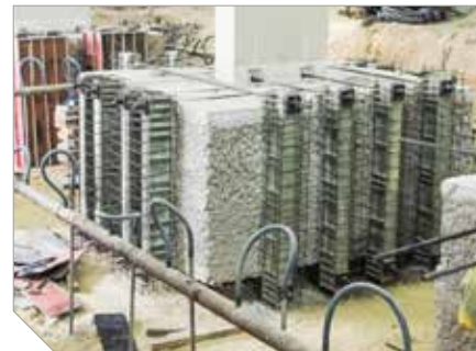
Colação dos perfis metálicos e das barras Dywidag, apicoamento das faces e colocação das armaduras, para recuperação dos blocos afetados
