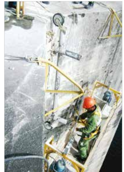
▶ Figura 10 Sistema de alinhamento do cabo diamantado
