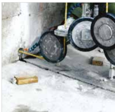
► Figura 8 Detalhe do resfriamento do cabo
