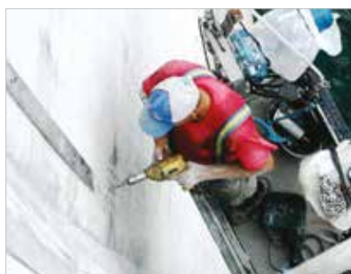
► Figura 17 Fixação dos perfis de inox
