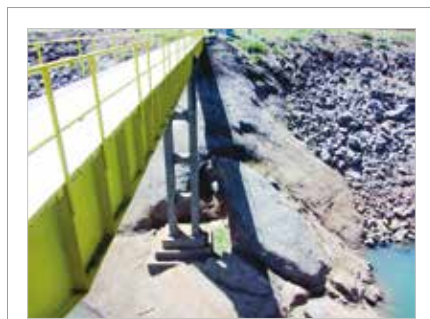
► Figura 11 Vista da passarela, apoiada sobre pilares e blocos
