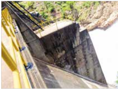
► Figura 2 Fissuração aleatória e eflorescências na lateral do contraforte (a) e na região da viga munhão (b)
