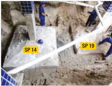
► Figura 11 Serviço de escavação das sapatas
