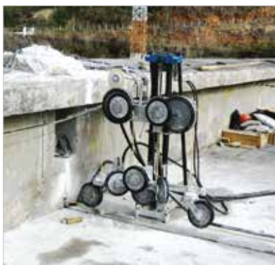
► Figura 7 Equipamento de corte
