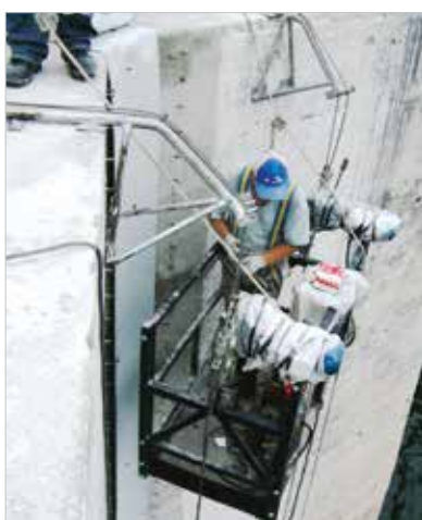
► Figura 19 Colocação da manta da base
