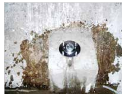
► Figura 23 Detalhe da fixação da cabeça do extensômetro
