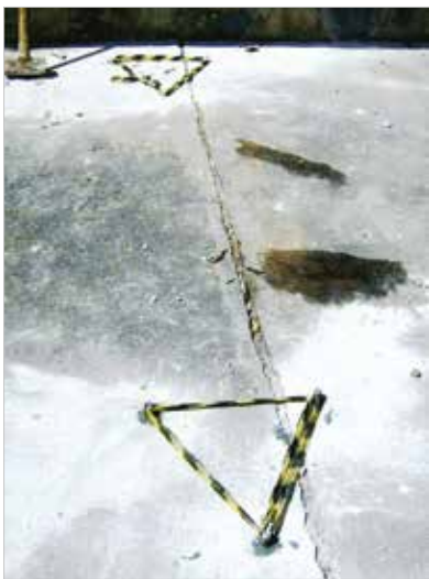
► Figura 12 Bases de alongâmetro na crista da barragem
