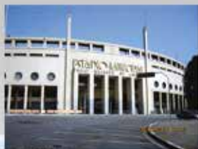
recuperação e reforço de edificações
