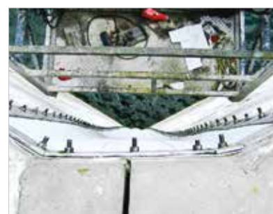
► Figura 20 Vista de cima da manta
