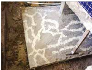
► Figura 15 Colmatação das trincas e fissuras
