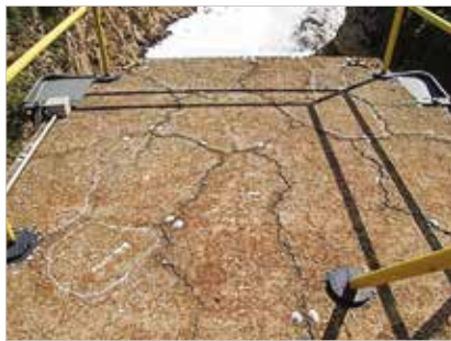
► Figura 3 Fissuras aleatórias no topo do contraforte – (a) e (b)
