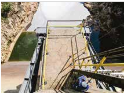
► Figura 3 Fissuras aleatórias no topo do contraforte – (a) e (b)
