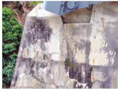
► Figura 2 Fissuração aleatória e eflorescências na lateral do contraforte (a) e na região da viga munhão (b)
