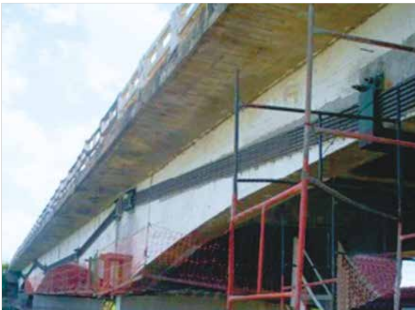
► Figura 8 Reforço das longarinas com protensão externa
