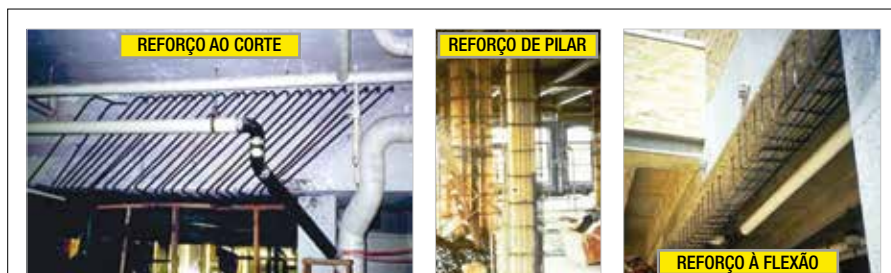
► Figura 12 Reforços leves com acréscimo de material resistente
