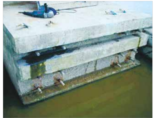
► Figura 12 Detalhe do bloco após o reforço
