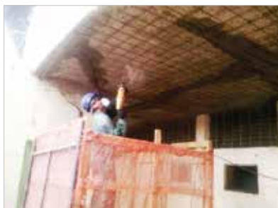
► Figura 11 Apicoamento na laje
