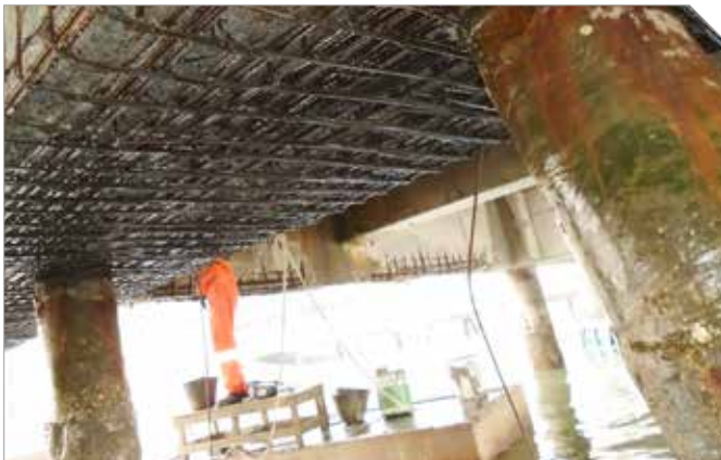
Trabalhos de recuperação e reforço em estrutura de acostagem
