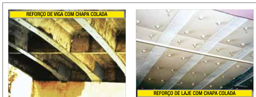
► Figura 13 Reforços com chapas metálicas aderidas externamente
