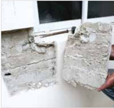
► Foto 15 Nota-se, na abertura da “janela” de inspeção, a existência de contraverga em concreto
