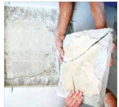
► Foto 17 Detalhe do deslocamento, das bases lisas e dos chapiscos indevidos (virado na obra) sobre concreto
