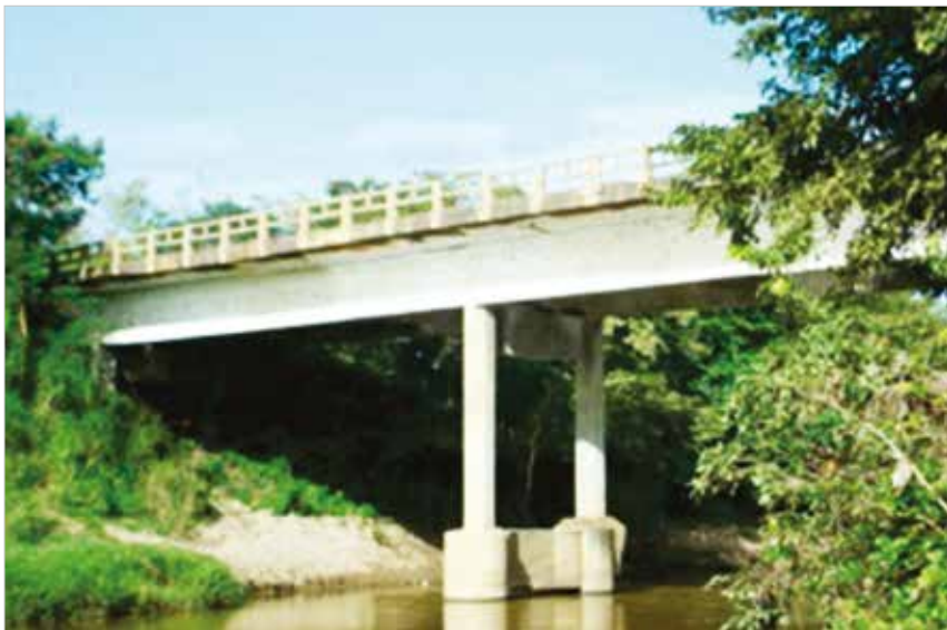
► Figura 3 Vista parcial da ponte antes do alargamento
