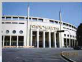
recuperação e reforço de edificações
