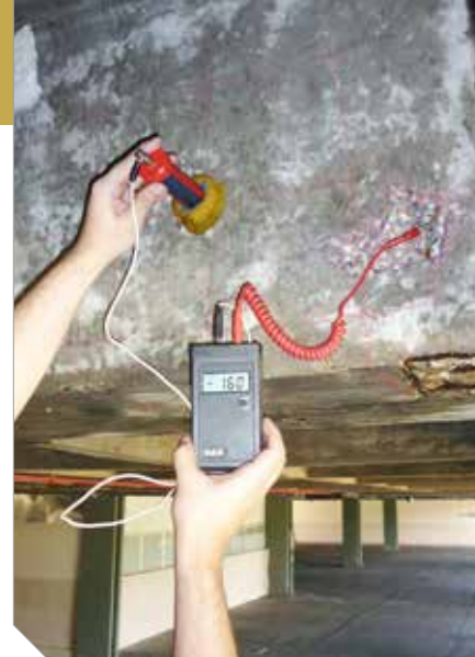
Ensaio de potencial elétrico de corrosão em elemento de concreto armado
