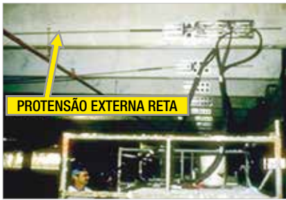
► Figura 17 Reforço com protensão leve externa às vigas
