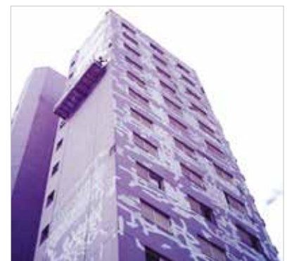
► Foto 6 Bandagem das fissuras
