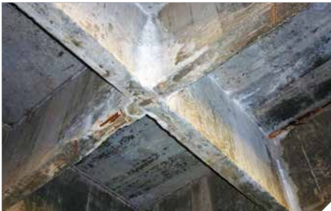
Eflorescências e armações corroídas em estrutura nervurada de concreto armado
