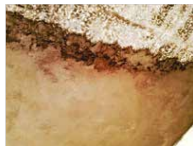
► Figura 14 Aspecto final após aplicação do graute
