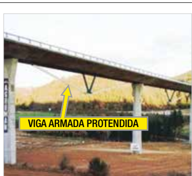
► Figura 19 Viaduto reforçado com “viga-armada” com tirante protendido
