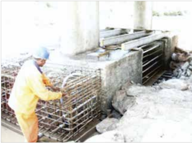
► Figura 11 Execução de reforço com cravação de estacas adicionais e aplicação de protensão no bloco
