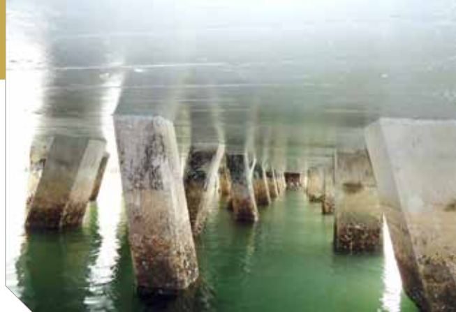
Aspecto final de pier após serviços de recuperação
