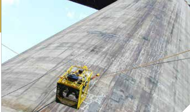
Execução de trabalhos de reparo em Silo de Carvão, na Colômbia
