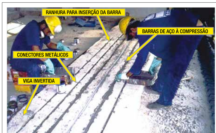
► Figura 10 Acréscimo de armadura para compressão, com aplicação de conectores para restringir flambagem
