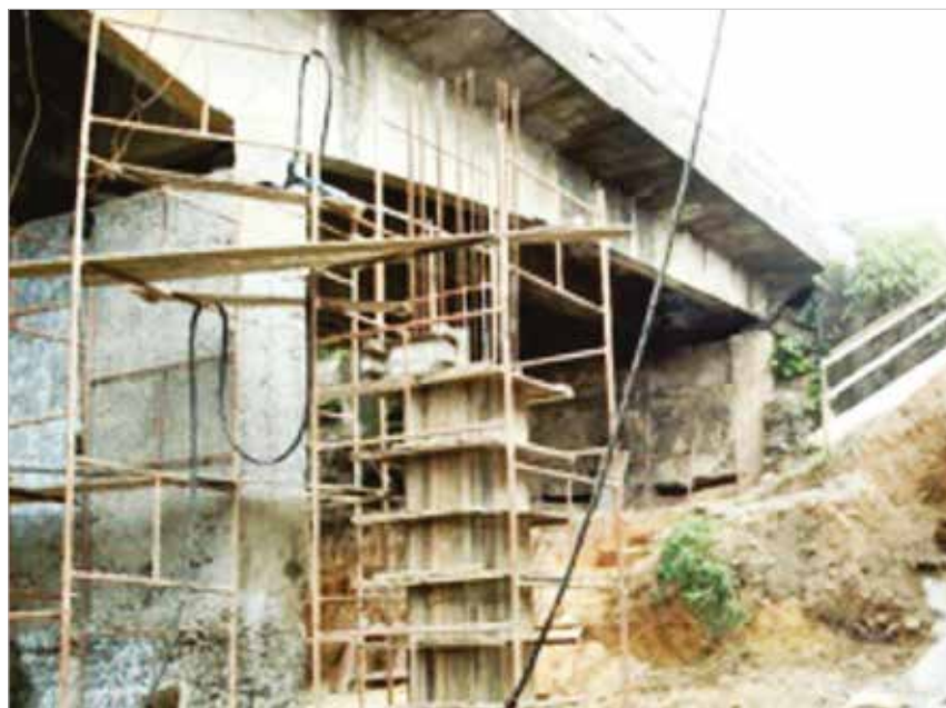
► Figura 6 Concretagem dos blocos das novas estacas
