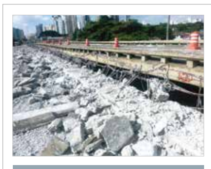
► Figura 15 Demolição de elementos não estruturais do viaduto
