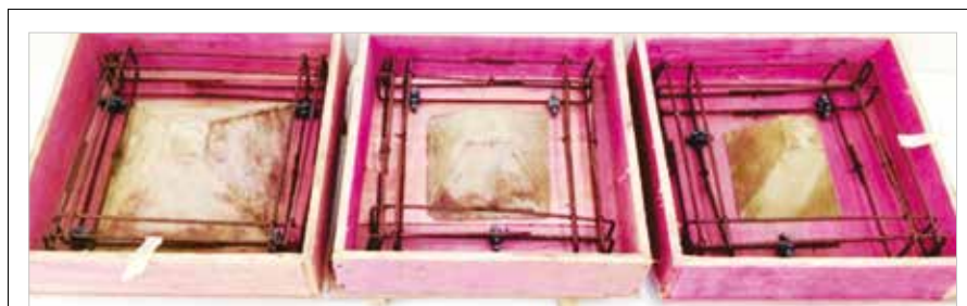
► Figura 5 Disposição dos núcleos concêntricos nas fôrmas antes do reforço
